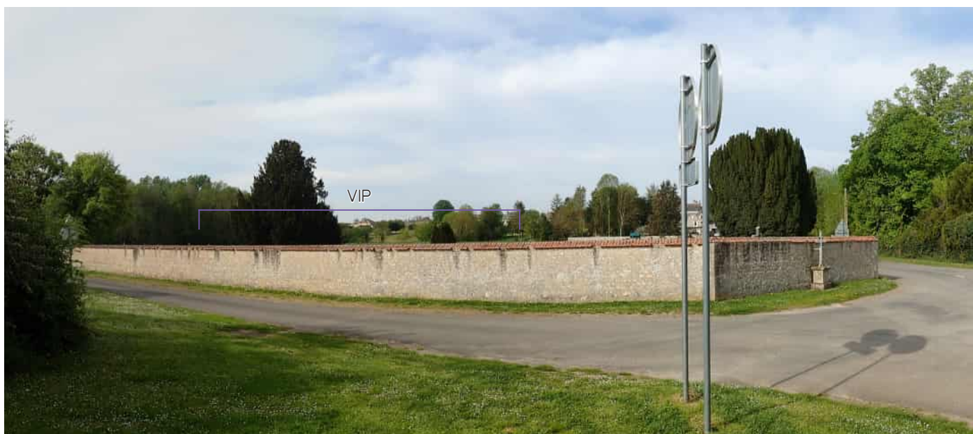
Photo 60 : Le VIP est partiellement visible en entrée est de Fontenay-sur-Conie, en partie masqué par la végétation de la vallée de la Conie
