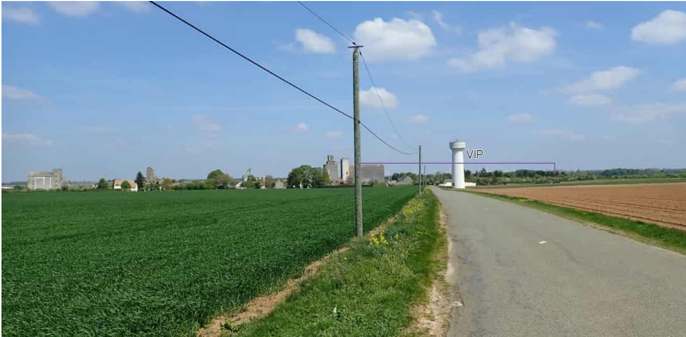
Photo 56 : Depuis ce point au sud de Péronville, le VIP s'inscrit à l'arrière-plan de la silhouette formée par les silos agricoles et le château d'eau
