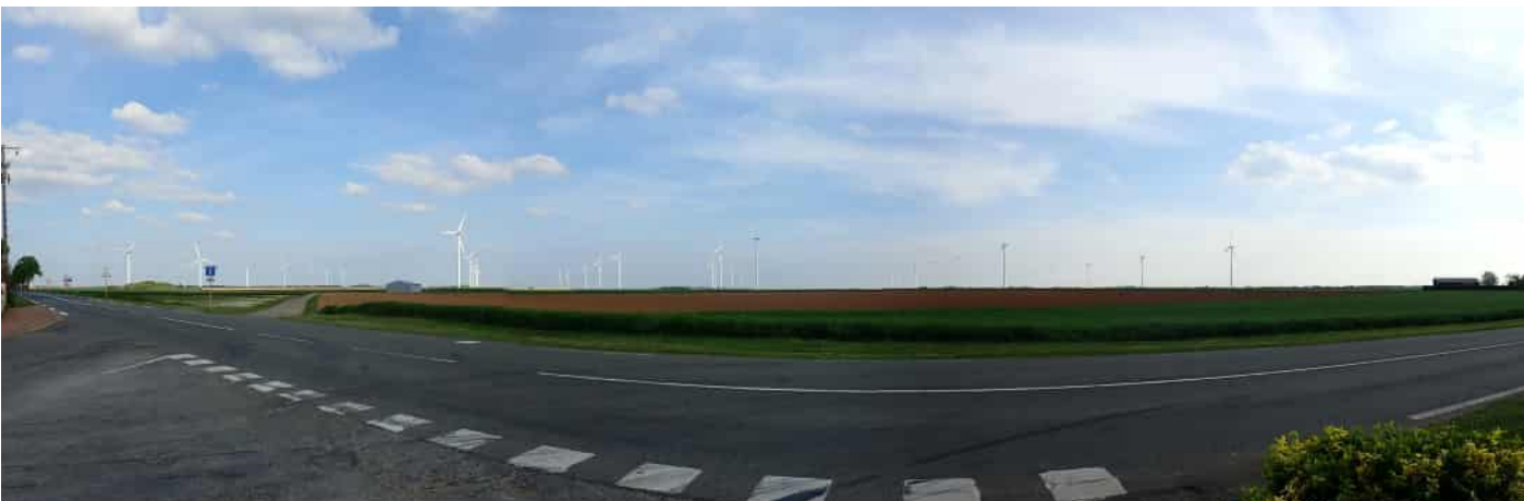
Photo 13 : Parcs éoliens situés dans la ZIP du projet depuis le sud de Cormainville au nord-ouest de l'aire immédiate
