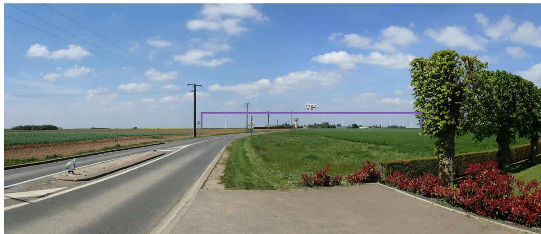
Photo 98 : Le VIP apparaît pleinement en sortie de bourg nord-ouest, selon une hauteur apparente plus élevée que celle des éoliennes actuelles, après avoir dépassé le parking arboré du cimetière de Guillonville
