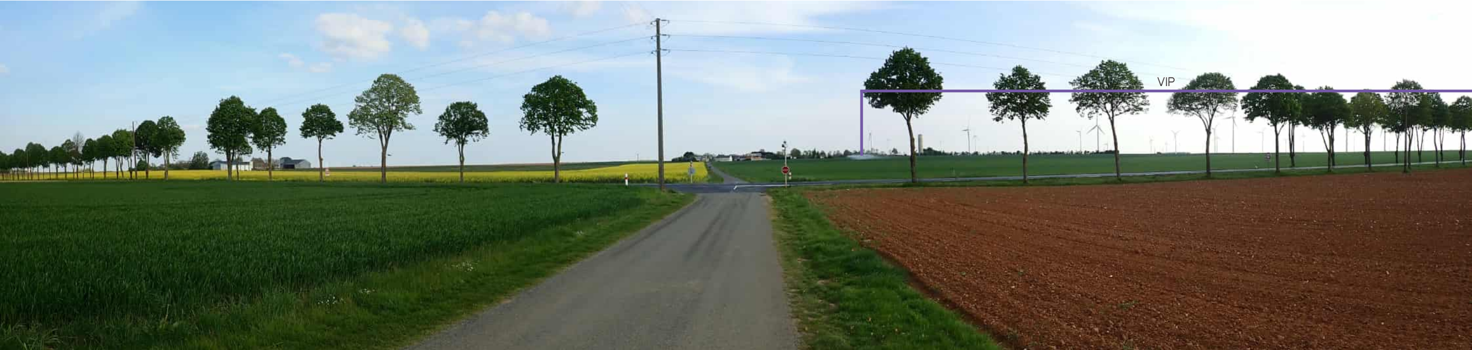
Photo 120 : Les arbres d'alignement de la RD 927 limitent la prégnance du VIP depuis le lieu-dit du Moulin de Mongé, sa visibilité est toutefois importante avec une hauteur apparente supérieure à celles des éoliennes existantes
