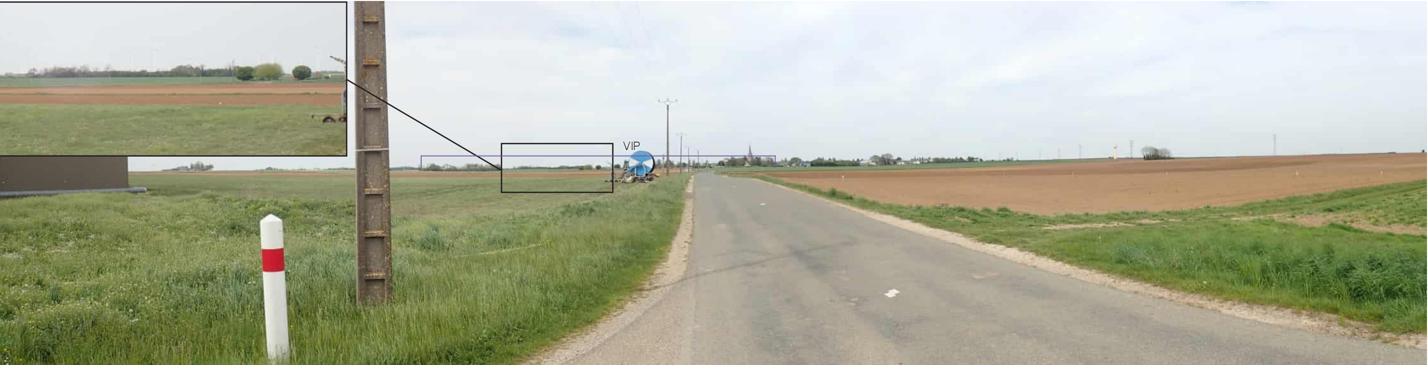
Photo 69 : Le VIP est visible au loin sur une emprise significative, en covisibilité avec le clocher ; sa hauteur apparente est inférieure à celle de l'édifice
