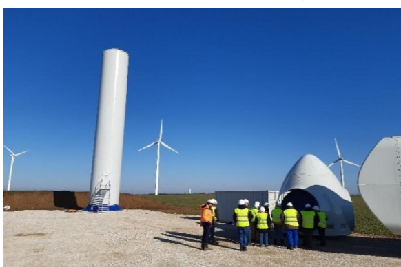
Figure 4 : Visite de chantier de la Ferme éolienne du Bois Elie (février 2023)
