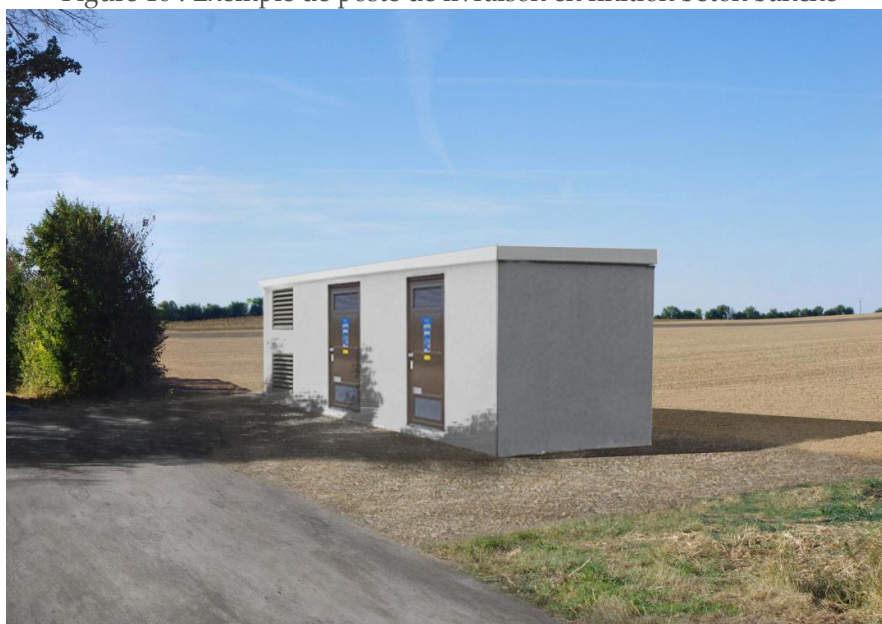
Figure 10 : Exemple de poste de livraison en finition béton banché
