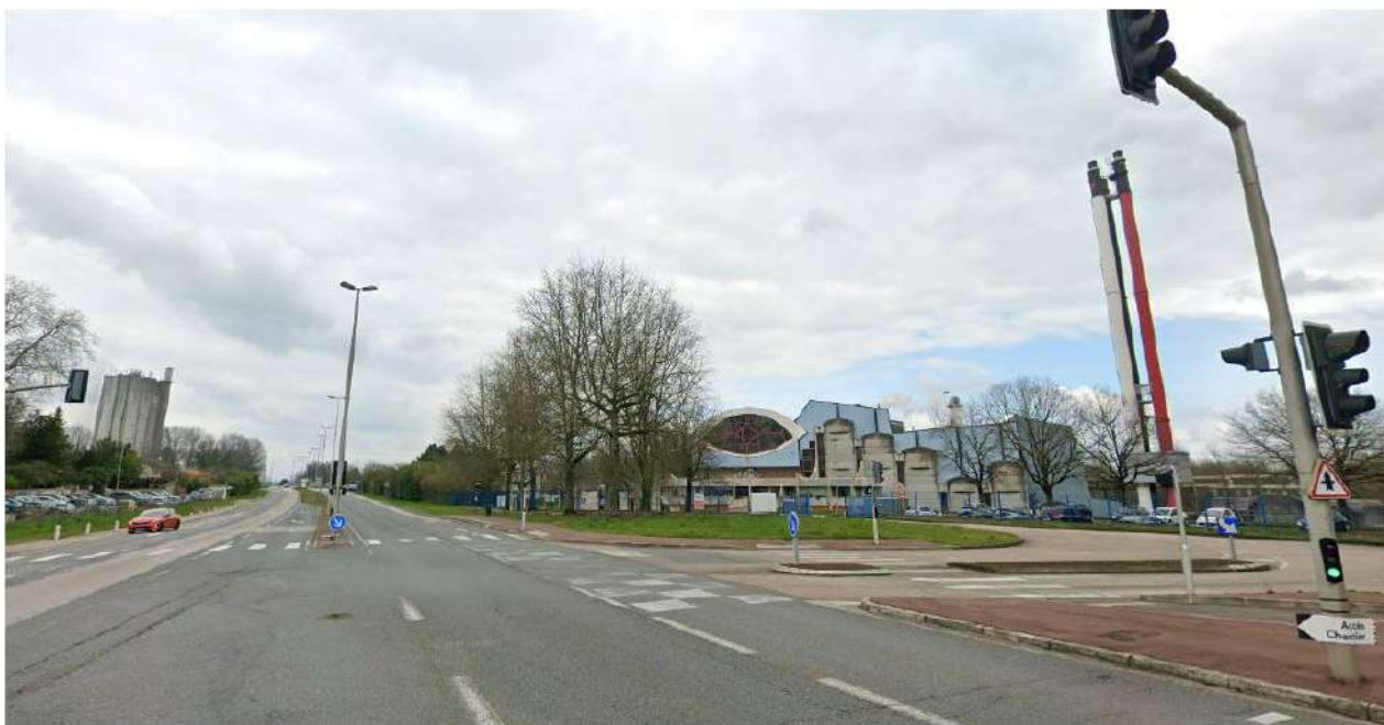
Vue sur l'UVE actuelle depuis la rue de Fougères
