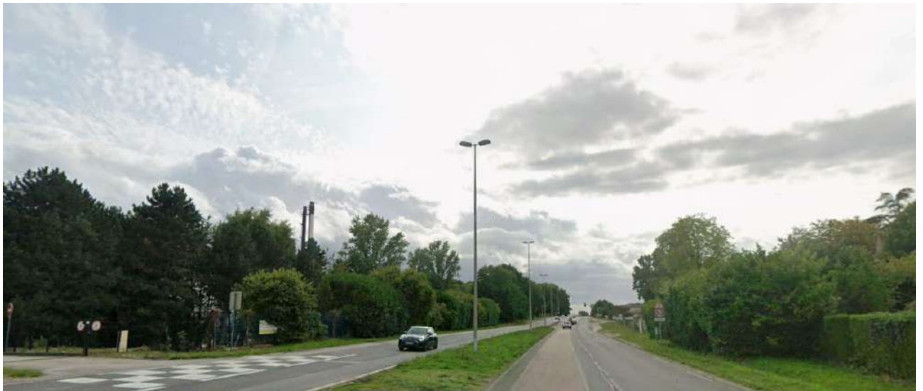
Figure 53 : Prise de vue n°2 - Vue de puis la rue de Fougères (source : Google Street View)
