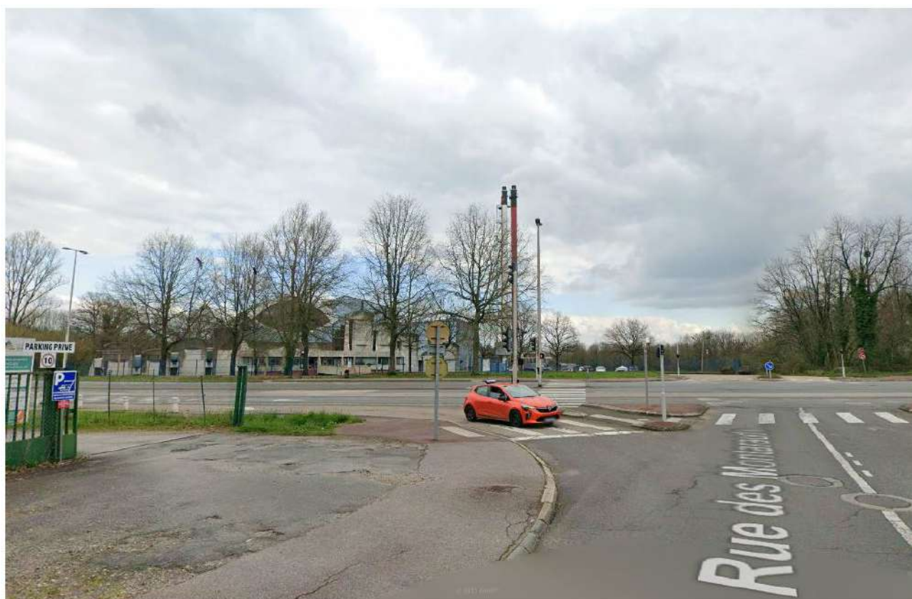
Vue sur l'UVE actuelle depuis la rue des Montarauds
