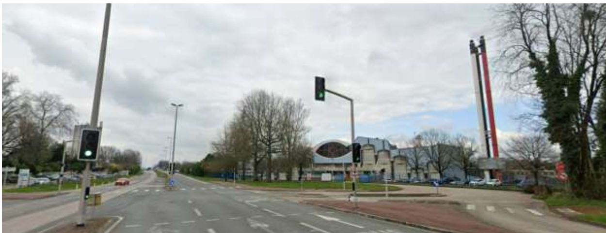
Figure 119 : Façade de l'UVE actuelle depuis la rue de Fougères
