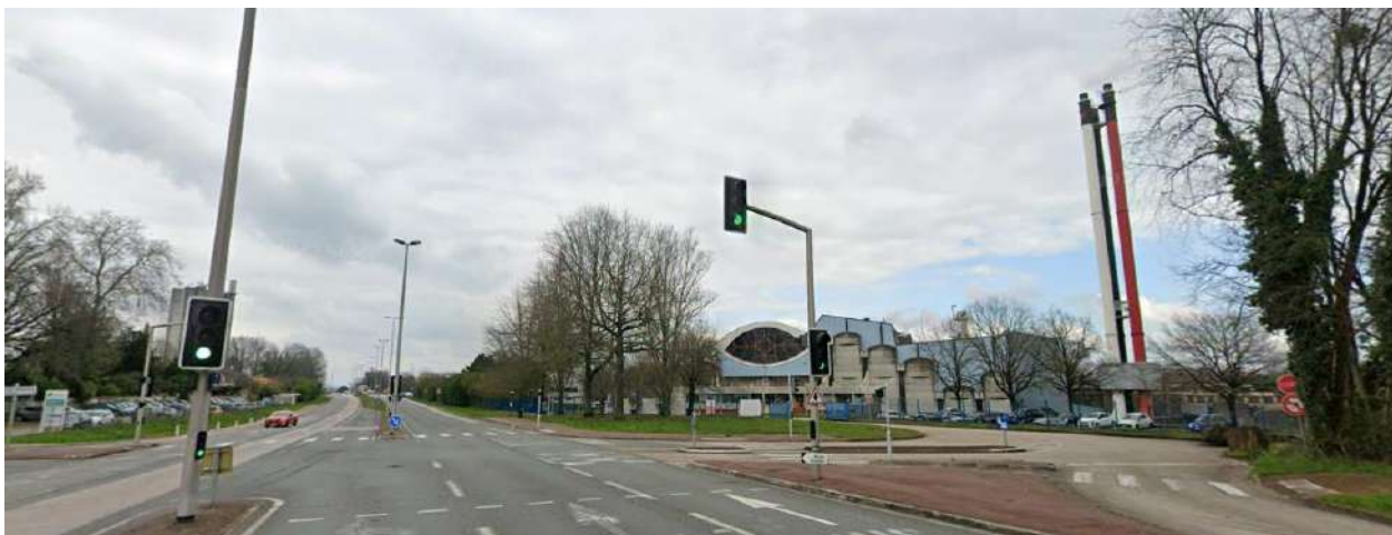
Figure 9 : Façade de l'UVE actuelle depuis la rue de Fougères
