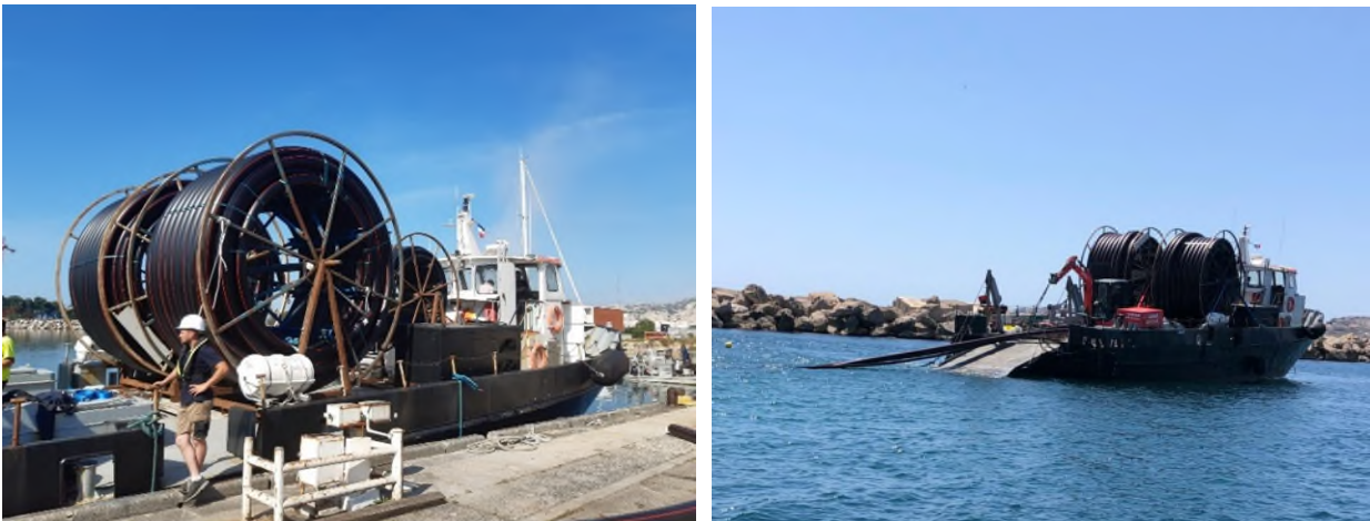
Figure 18 - Moyens nautiques mis en œuvre pour une solution tubage
