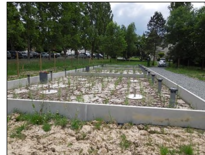
Figure 7 - Exemple d'un premier étage de filtration (jeunes pousses) et regard de mise en charge
