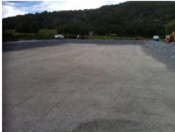
Figure 18 - Réglage du fond au 0/31.5 compacté
