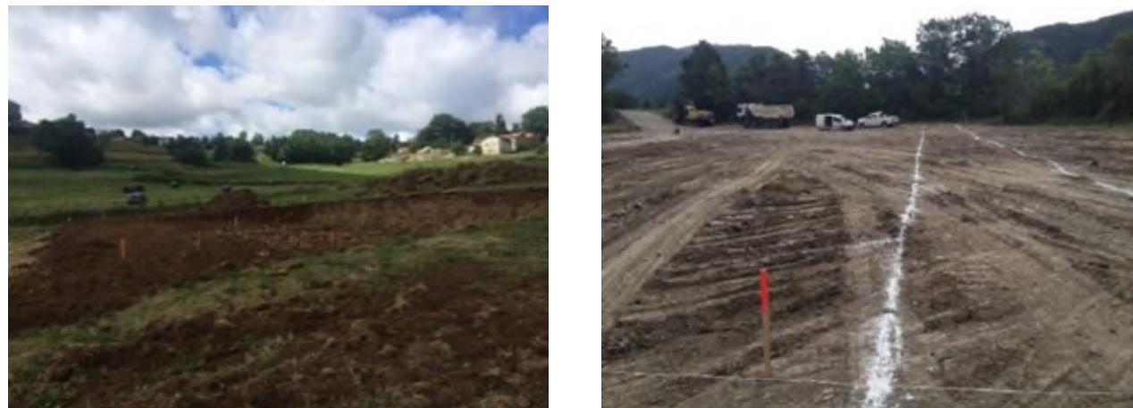
Figure 16 - Exemple de piquetage (Source : ISTEPP - SETP)
