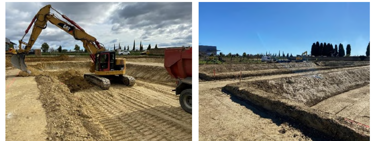
Figure 17 - Exemple de terrassement pour des filtres plantés (Source : ISTEPP - SETP)
