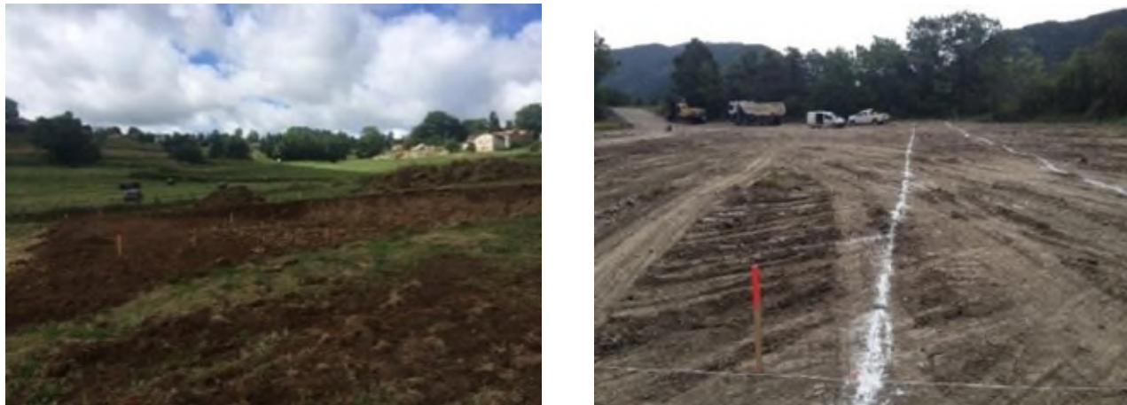
Figure 16 - Exemple de piquetage (Source : ISTEED - SETP)
