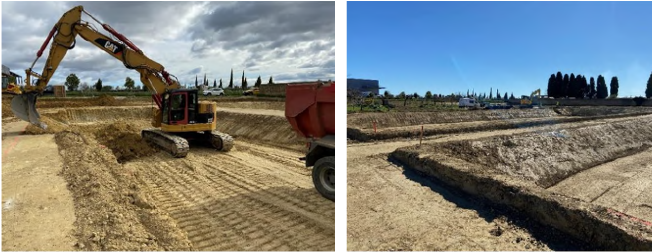
Figure 17 - Exemple de terrassement pour des filtres plantés (Source : ISTEED - SETP)
