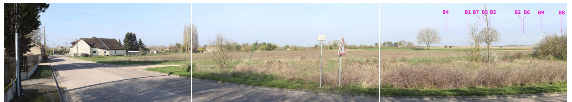
Photo 97 : Photomontage depuis le point de vue n°12 depuis Abbaye-sous-Plancy, à l'intersection entre la rue des Marronniers et la Sente Saint-Martin, 2 507m du projet, angle de 120° (Source : BEJC)
