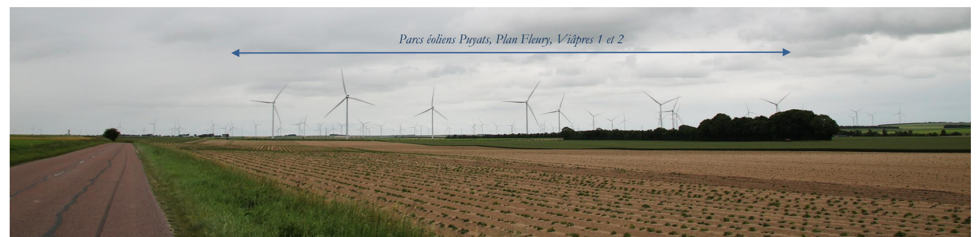
Photo 32 : Vue vers les parcs construits à l'Est de la ZIP, sur la D7 au Nord de Plancy-l'Abbaye (Source : BEJC)
