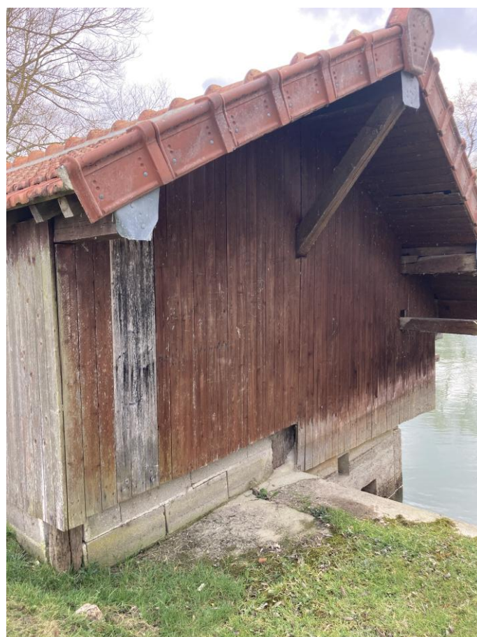
Photo 3 : Le lavoir de Boulages (Source : WPD)
