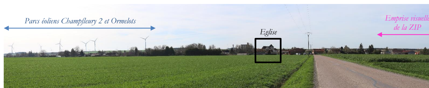
Photo 56 : Des situations de covisibilités existent déjà entre l'église de Salon et les éoliennes construites (Source : BEJC)
