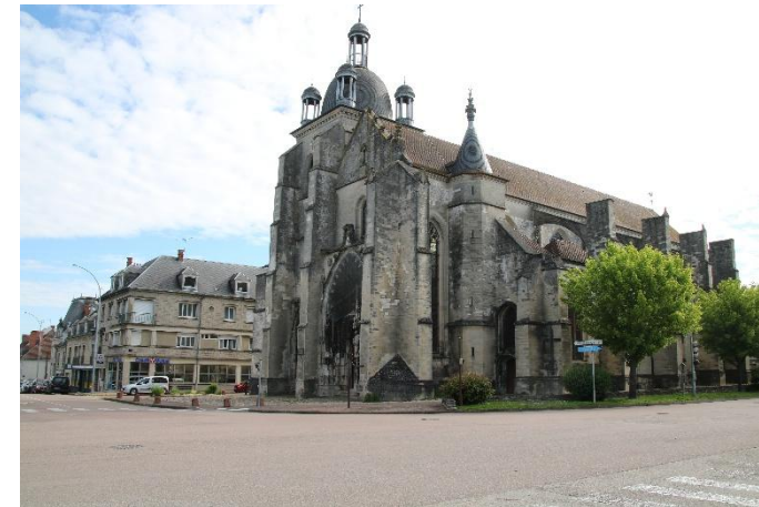
Photo 59 : L'église d'Arvis-sur-Aube (Source : BEJC)
