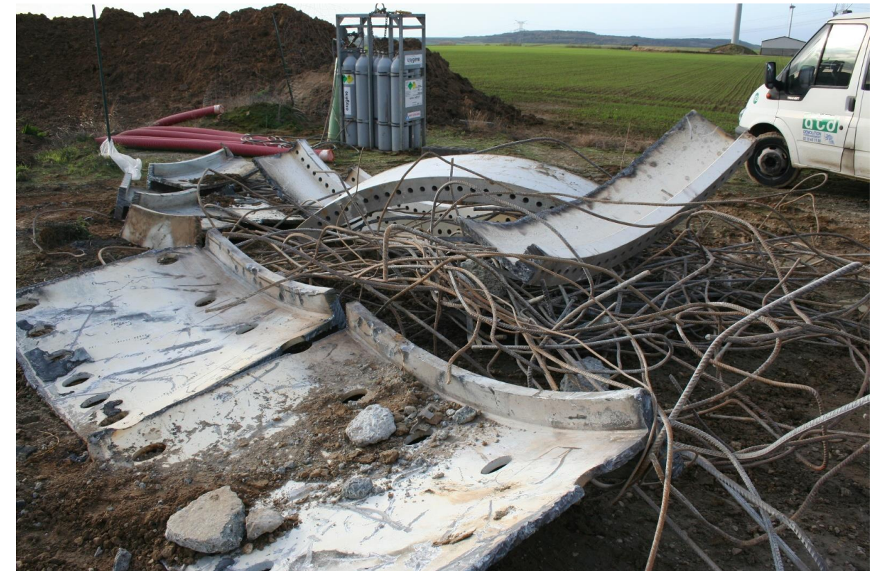
Figure 11 : Triage de la ferraille lors d'une destruction de fondation (Source : Valrea)
