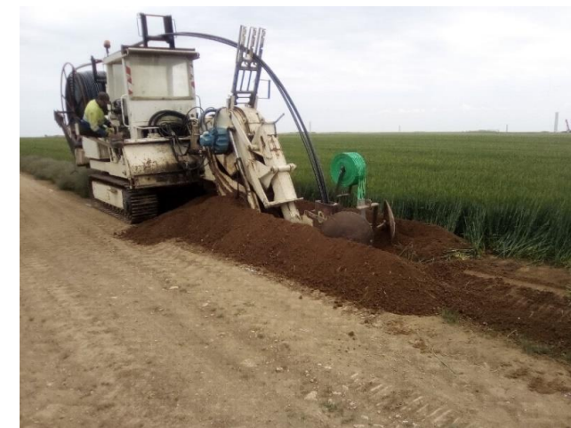
Photo 11 : Pose d'un câble HTA à 1,20 m avec la méthode de la trancheuse (source VALOREM)
