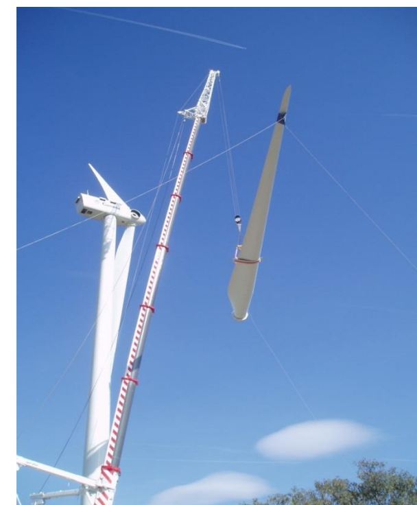
Photo 23 : Montage pale par pale (Source EDF EN)
