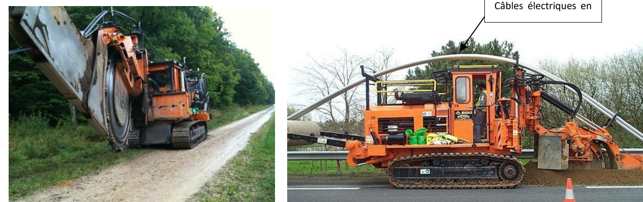
Photo 15 et Photo 16 : Trancheuse à l'arrêt et en action (Source : ENGIE GREEN)
