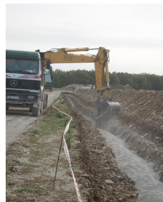
Photo 12 : Sablage (Source Enedis)
