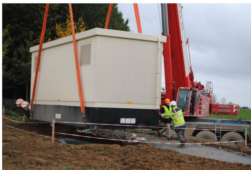
Photo 14 : Pose d'un poste de livraison (Source EDF EN)
