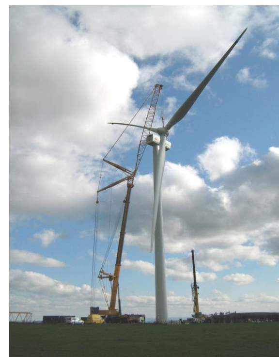
Photo 22 : Montage du rotor (Source Engie Green)
