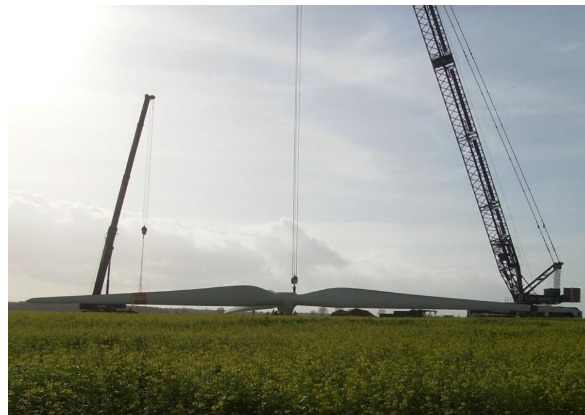
Photo 21 : Assemblage du rotor au sol (Source Vestas)
