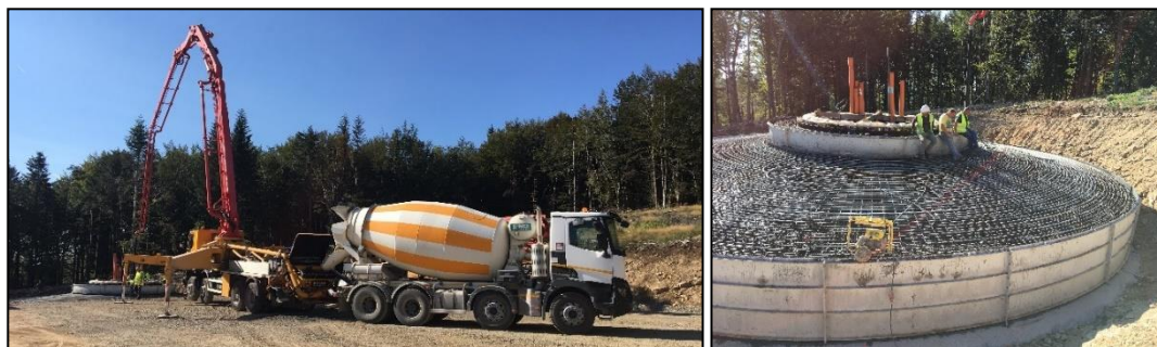
Photo 9 : Coulage du béton (Source : Artifex 2018)
