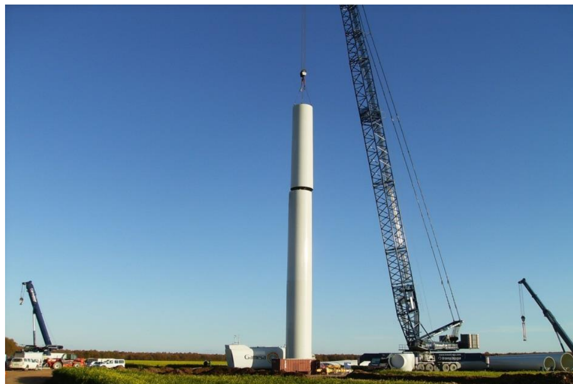
Photo 19 : Montage des éléments de la tour (Source : Thewindpower.net)
