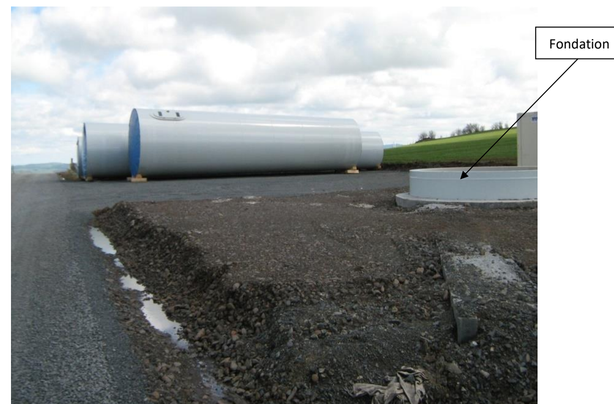
Photo 18 : Stockage des éléments de l'éolienne sur la plateforme à proximité de la fondation (Source : Thewindpower.net)
