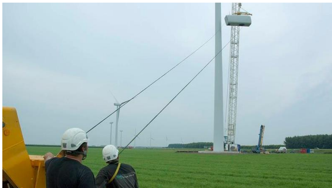
Photo 20 : Montage de la nacelle (Source : Thewindpower.net)
