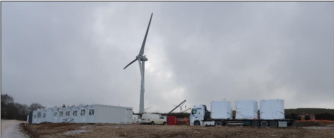
Photo 6 : Base vie (Source : Artifex 2018)
