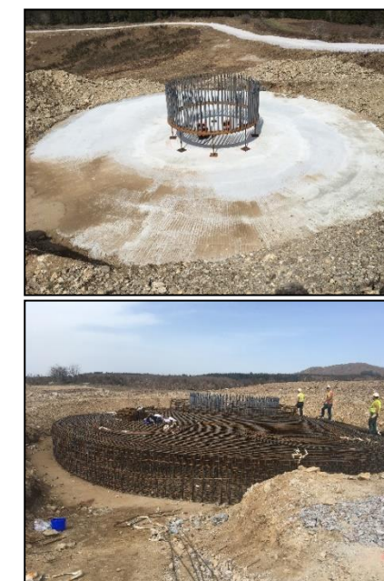
Photo 8 : Montage de l'armature (Source : Artifex 2018)
