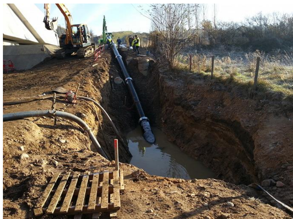
Photo 17 : Exemple de point de départ avec canalisation engagée (Source : ENGIE GREEN)
