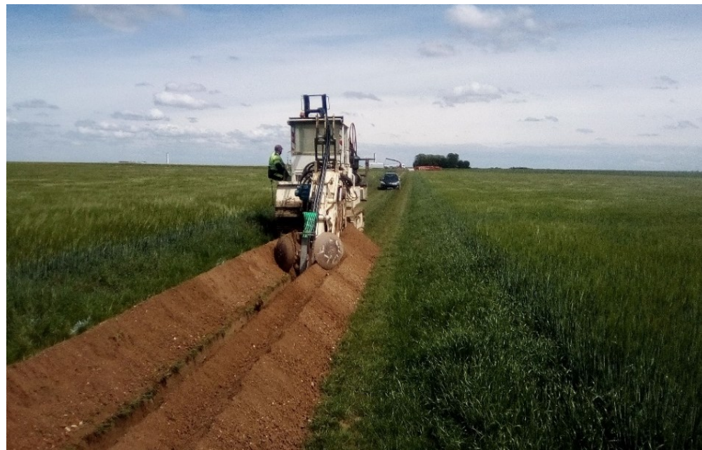
Figure 173 : Tranchée pour le passage de réseau électrique HTA à partir d'une trancheuse.
