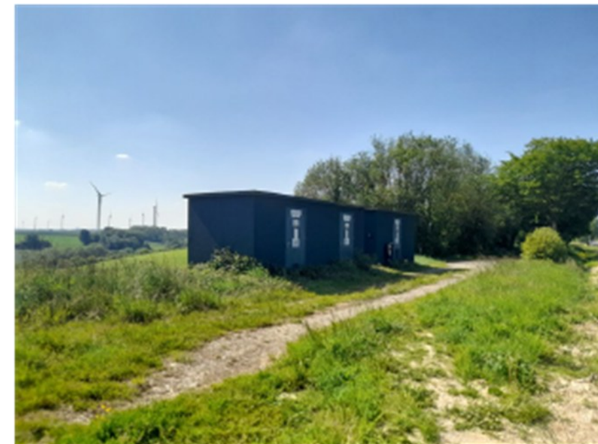
Figure 179 : photo de référence d'un poste de livraison vert foncé
