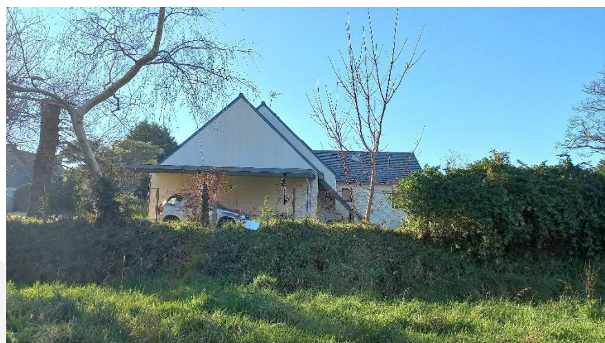
Figure 56 : Photographie du point de mesure n° 3
