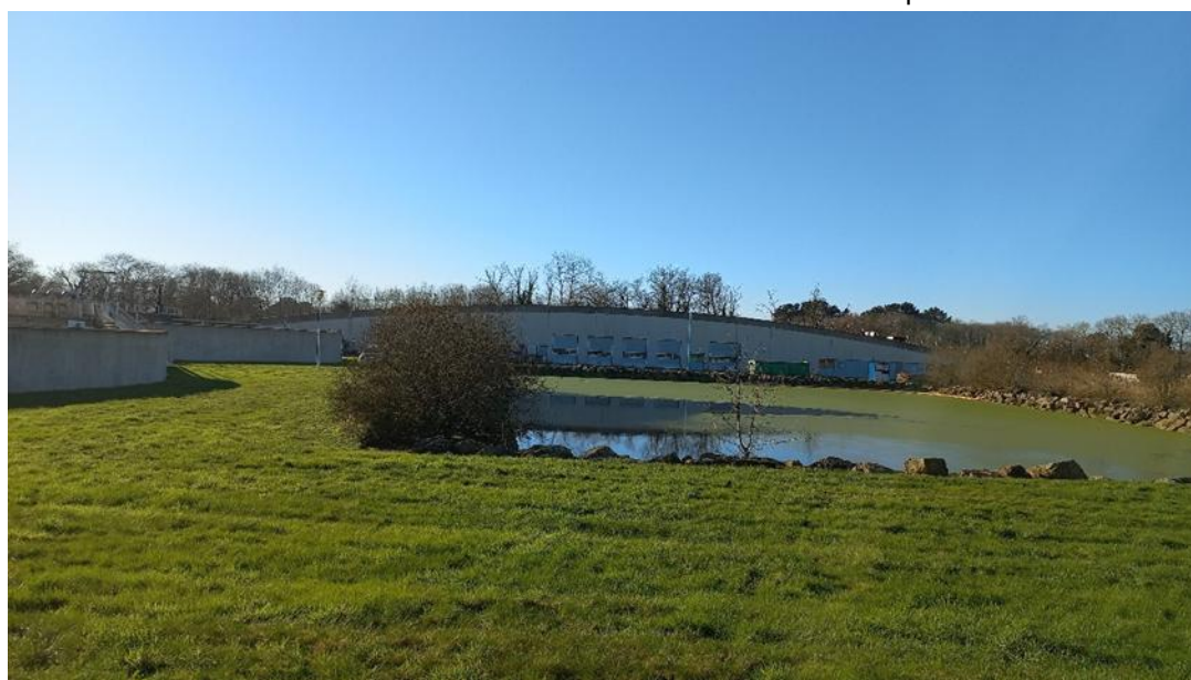
Figure 58 : Vue de la station d'épuration
