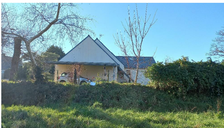
Figure 3 : Photographie du point de mesure n° 3
