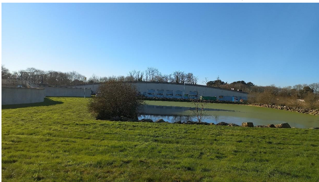
Figure 5 : Vue de la station d'épuration
