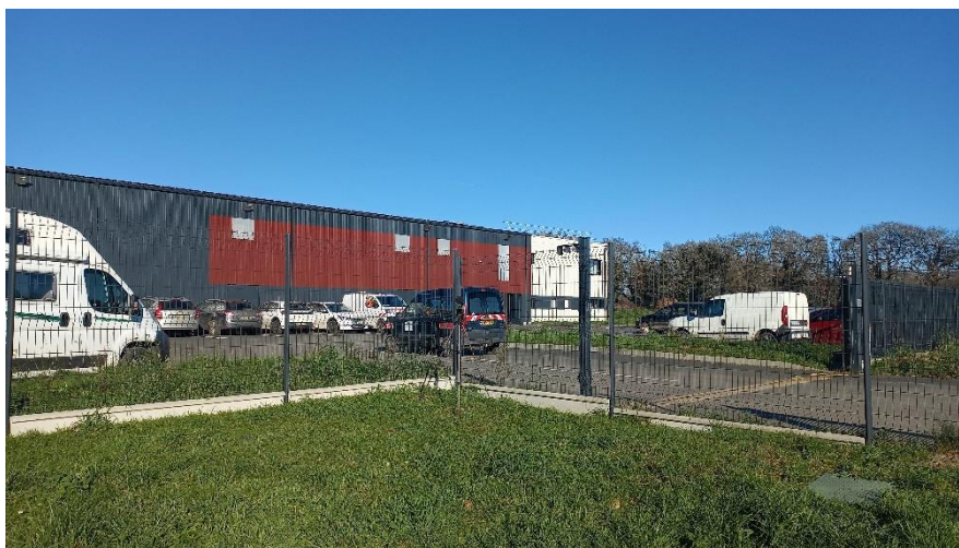
Figure 2 : Photographie du point de mesure n°2
