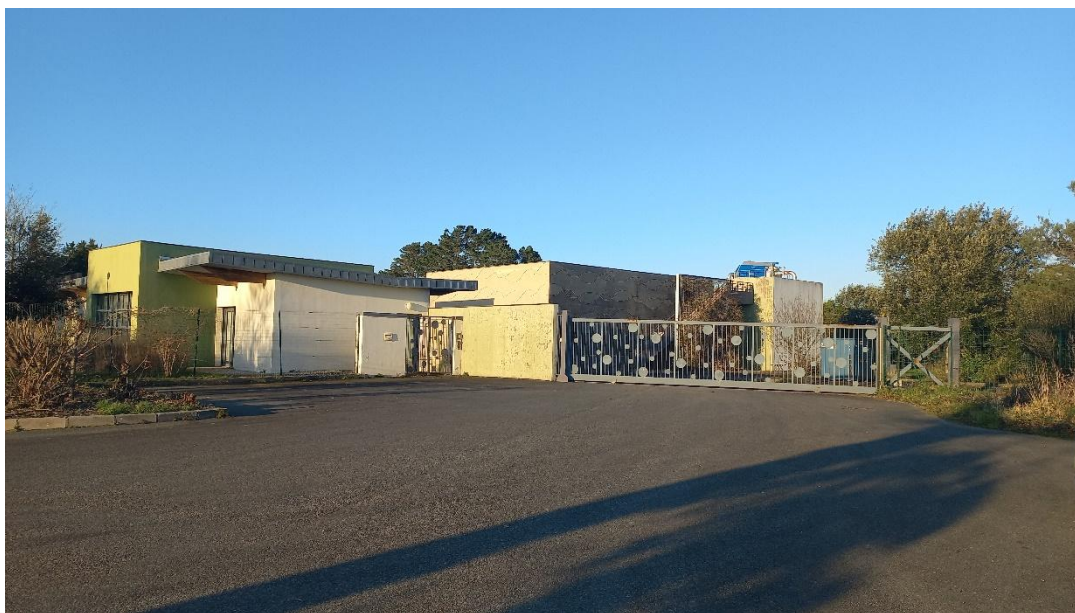
Figure 58 : Vue de la station d'épuration
