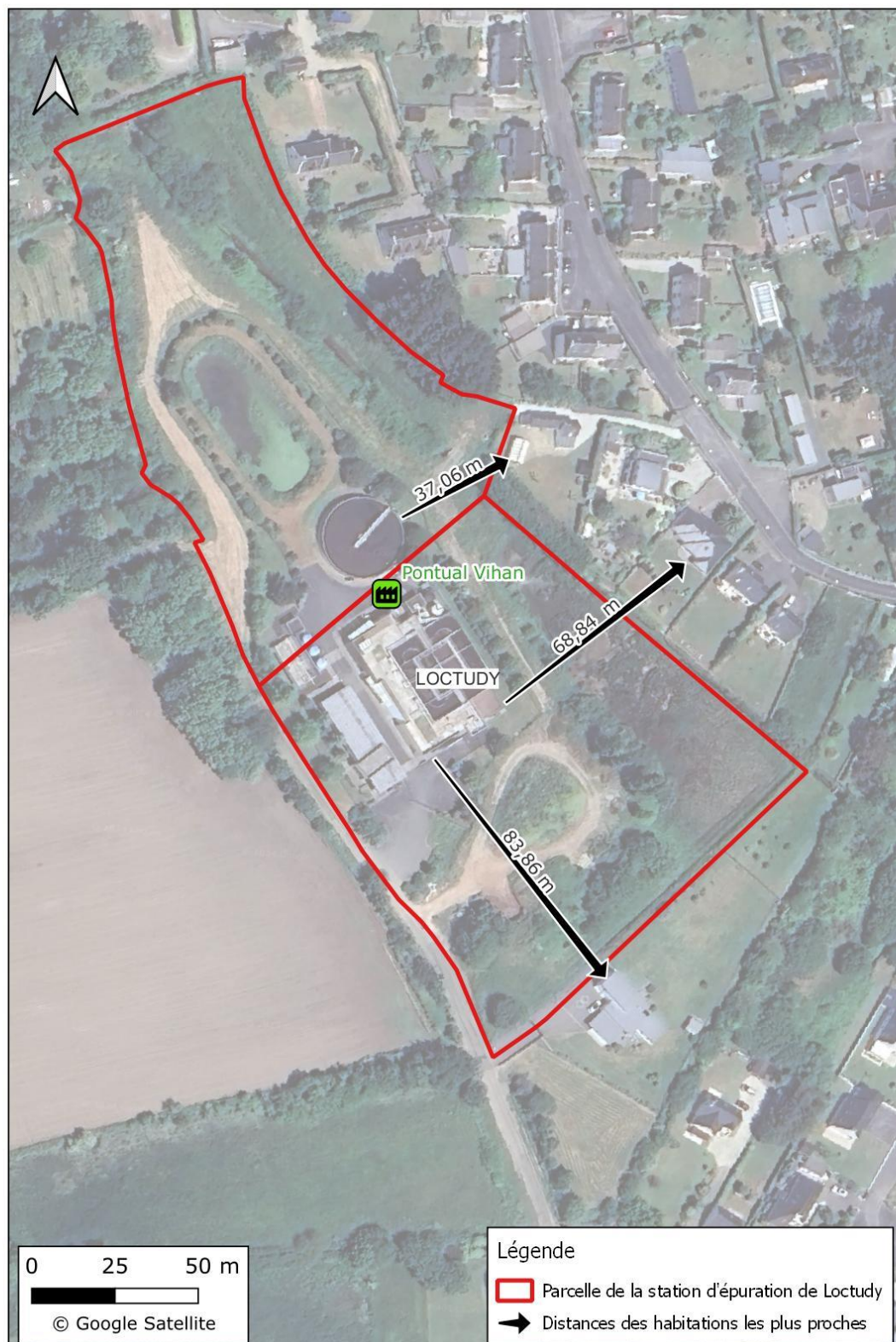
Figure 41 : Distance des habitations du site de la STEP de Loctudy
