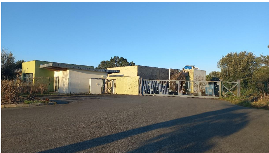
Figure 5 : Vue de la station d'épuration
