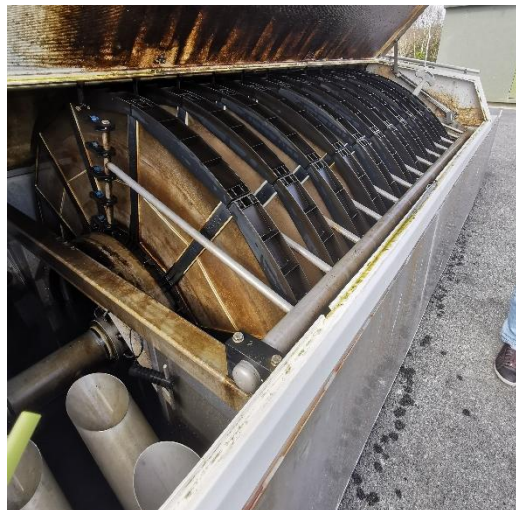
Figure 22 : Hydretech (Source : Station d'épuration équivalente dans le même secteur)
