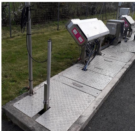
Figure 23 : Dispositif UV (Source station d'épuration équivalente dans le même secteur)
