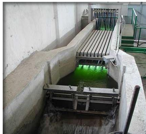
Figure 21 : Dispositif UV (source : Trojan UV 3000 plus)
