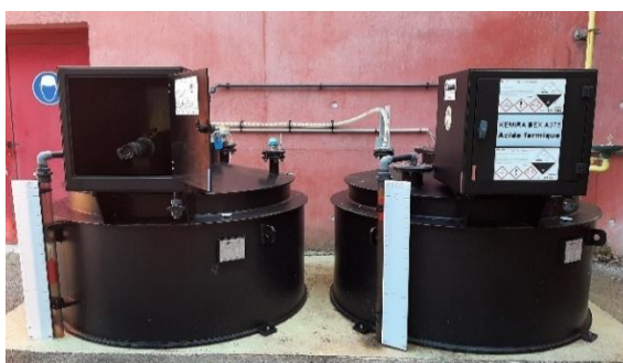
Figure 24 : Cuve d'acide formique et de peroxyde d'hydrogène (à gauche) et Unité de production (à droite)
