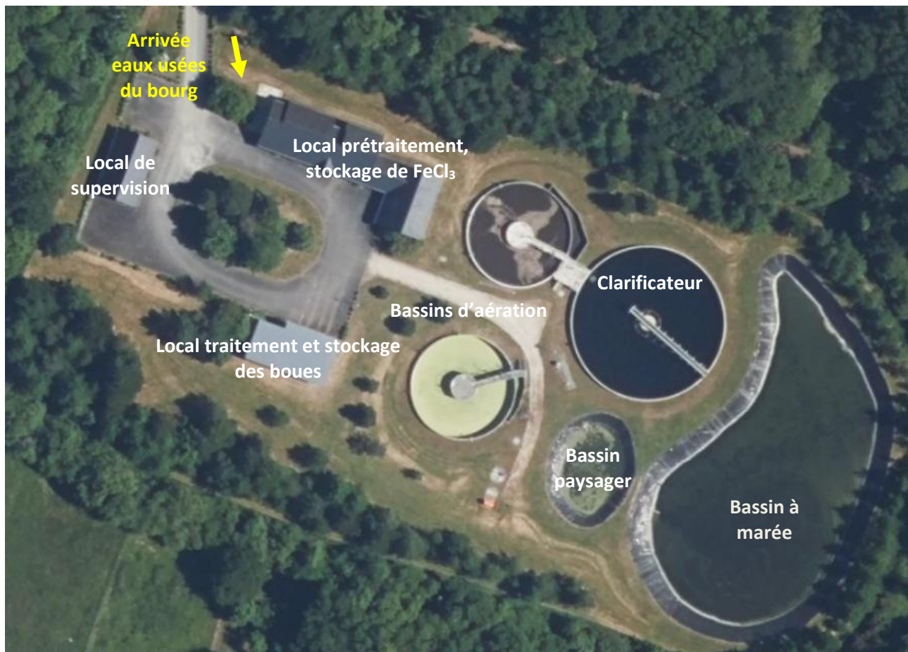
Figure 1: Vue aérienne de la station d'épuration (source : Géoportail)
