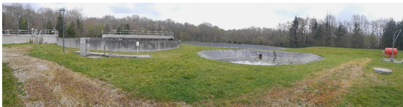
Figure 4. Station d'épuration de Combrit (Source : ©Biotope)
