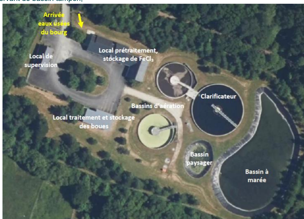
Figure 5. Vue aérienne de la station d'épuration de Combrit (Source : B3E)
