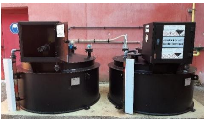
Figure 11. A gauche – Cuve d'acide formique et de peroxyde d'hydrogène – A droite – Unité de production (Source : B3E)
