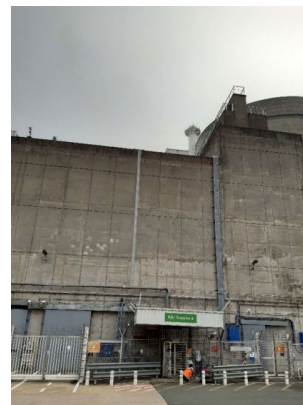
Cheminées de rejets des effluents radioactifs atmosphériques de la centrale © EDF
