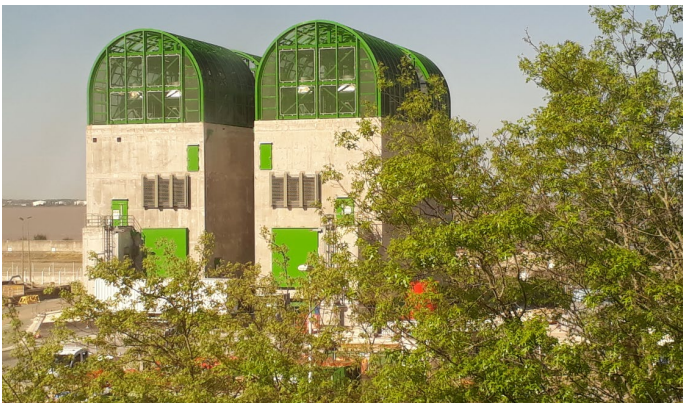
Diesels d'Ultime Secours (DUS) de 3 MWe
