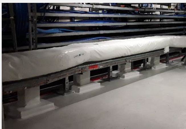
Exemple de protection de chemin de câbles
