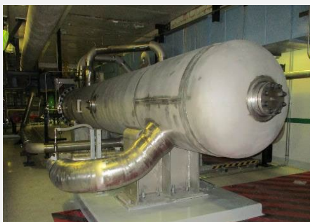
Échangeur du dispositif EAS-ND
