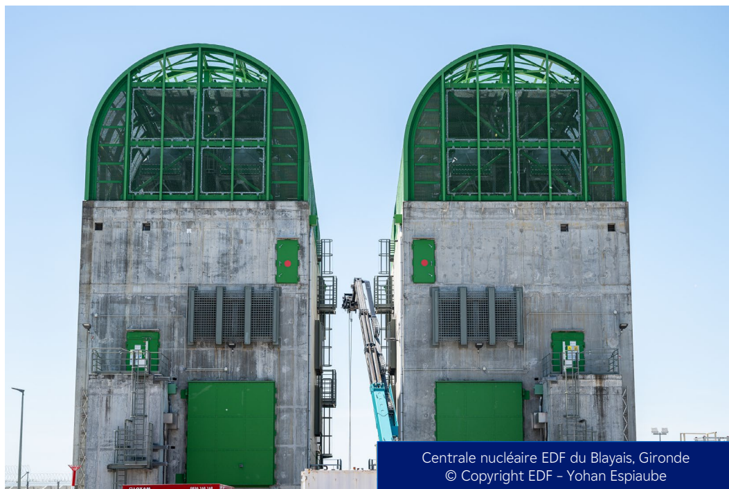
Figure 8. Photo de deux Diesels d'Urgence Secours (DUS) de 3 MWe
