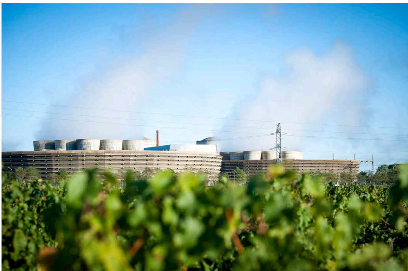
Centre Nucléaire de Production d'Électricité de Chinon.
