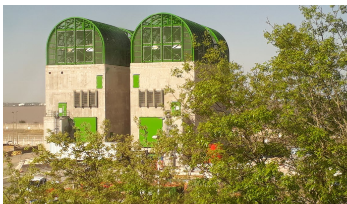
Diesels d'Ultime Secours (DUS) de 3 MWe
