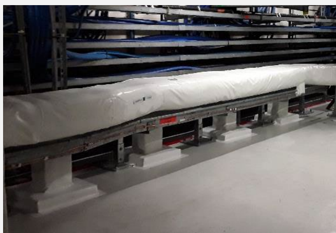
Exemple de protection de chemin de câbles
