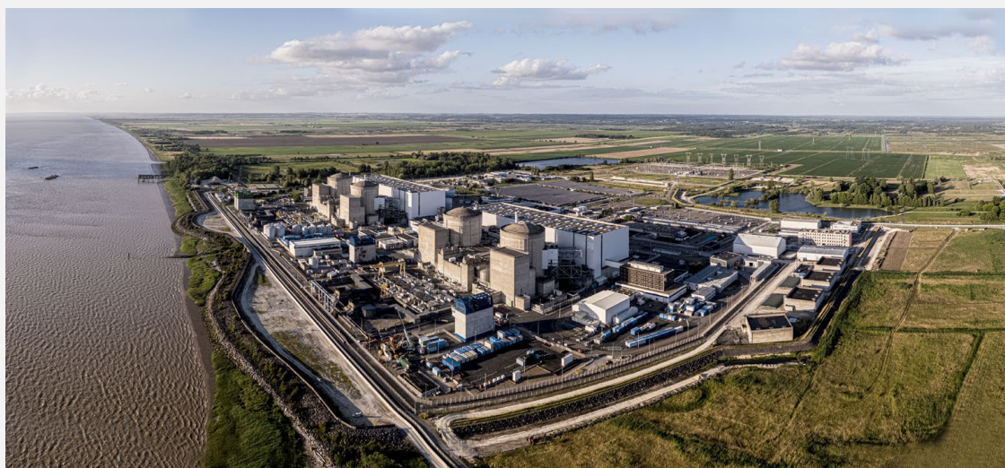
Protection périphérique de la centrale nucléaire du Blayais
