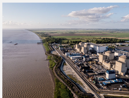
Vue aérienne de la centrale du Blayais côté estuaire ©Air Marine
