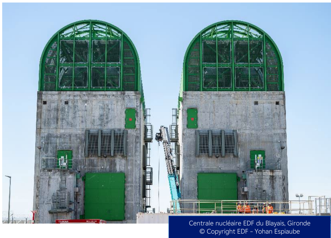
Figure 8. Photo de deux Diesels d'Ultime Secours (DUS) de 3 MWe
