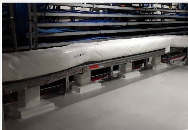
Exemple de protection de chemin de câbles
