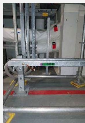
Ajout de supports pour les chemins de câbles
