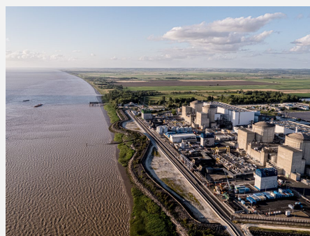
Vue aérienne de la centrale du Blayais côté estuaire ©Air Marine
