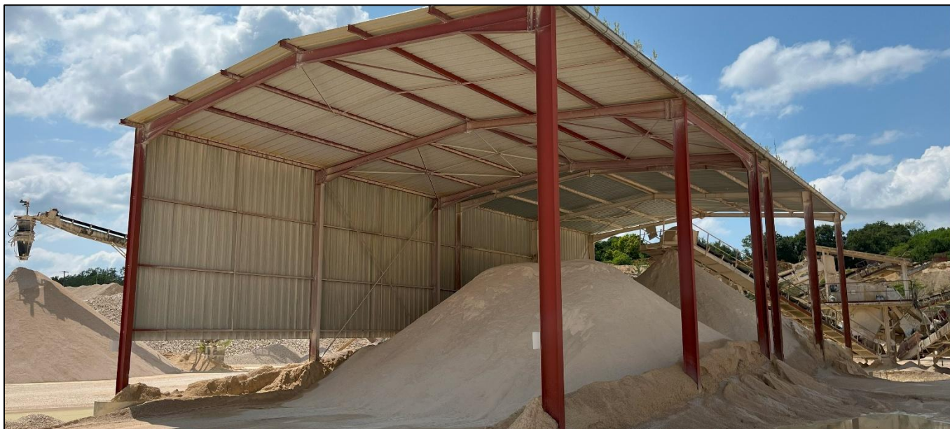
Photographie 5 : Zone de traitement et stockage des matériaux
