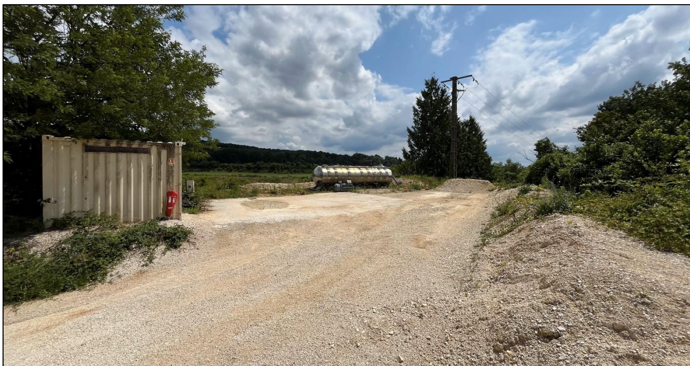
Photographie 4 : Aire étanche, local de stockage et citerne d'eau
