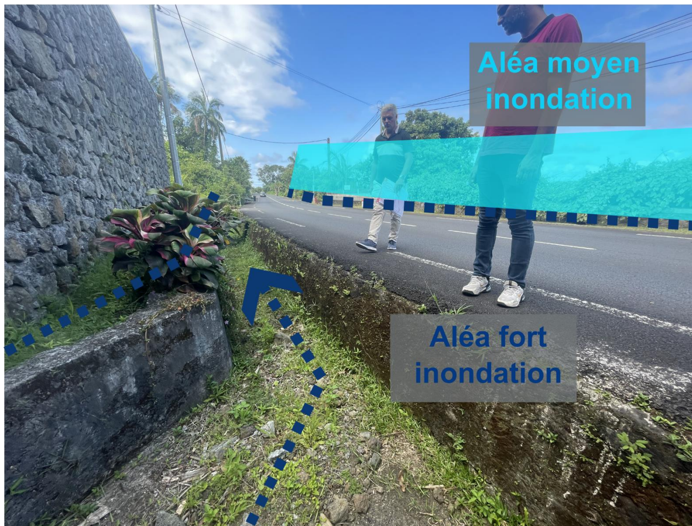
Figure 10 : Caniveau canalisant les écoulements d'eau le long de la RN2 avec un bandeau d'aléa moyen MVT sur 5 m de large en sortie de caniveau et un aléa moyen inondation sur la parcelle AK79.
