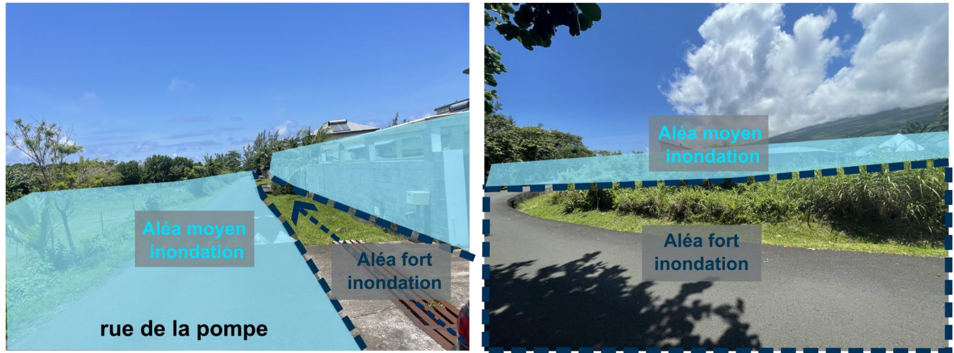
Figure 17 : Caniveau le long de la rue de la Pompe en aléa fort inondation (à gauche). Aléa fort inondation sur 10 m sur les parcelles AT1313 et AT1312, puis aléa moyen inondation (à droite)
