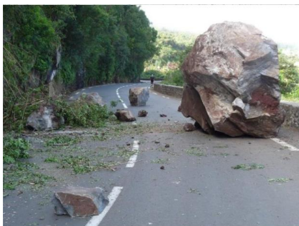
Chute de blocs, Basse Vallée – RN2 (2010)
