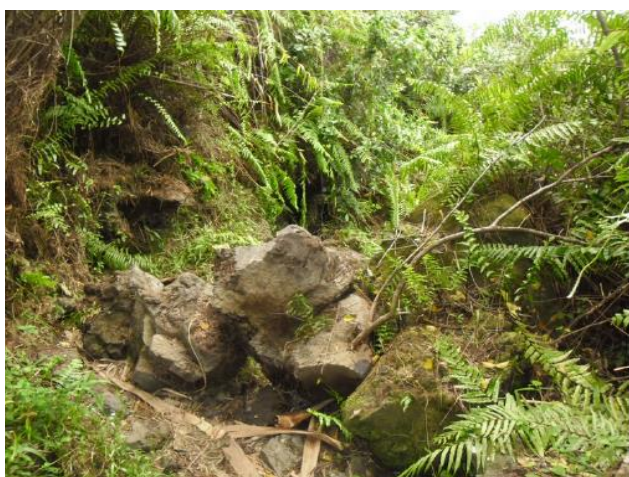
Chute de blocs – Sentier du Vieux Port (2018)
