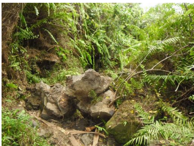
Chute de blocs – Sentier du Vieux Port (2018)
