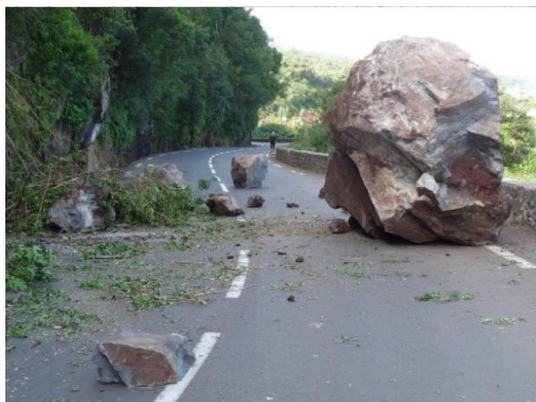
Chute de blocs, Basse Vallée – RN2 (2010)
