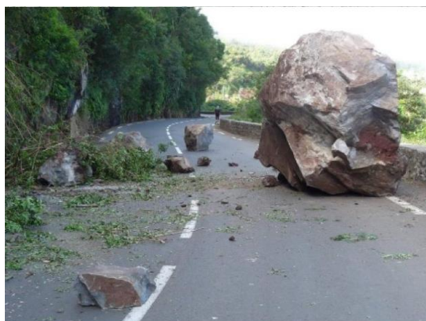
Chute de blocs, Basse Vallée – RN2 (2010)
