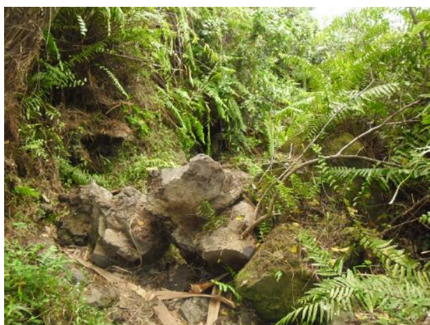
Chute de blocs – Sentier du Vieux Port (2018)
