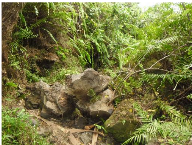
Chute de blocs – Sentier du Vieux Port (2018)
