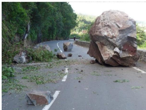
Chute de blocs, Basse Vallée – RN2 (2010)
