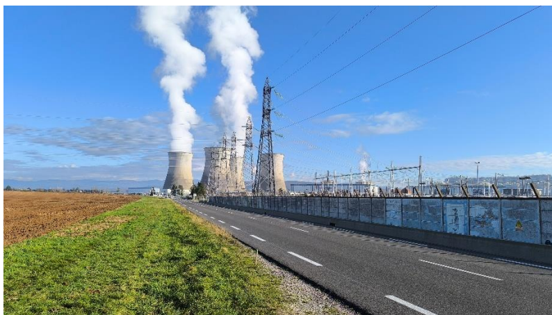
Figure 18 : Centrale nucléaire du Bugey
