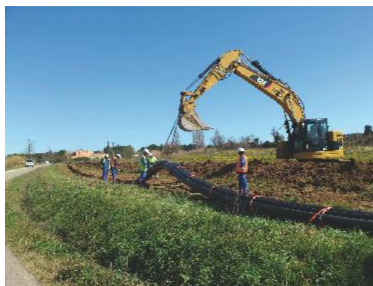
Pose des fourreaux PEHD en pleine terre
