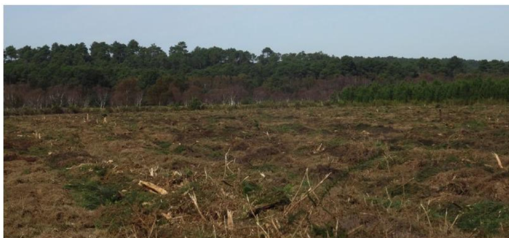
Photo 3 : parcelle îlot n°1 Palu de Molua pendant travaux de restauration - octobre 2017
