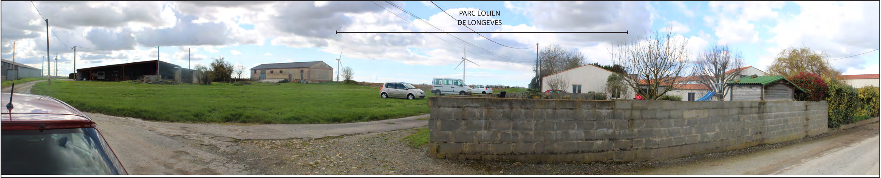
État initial - Vue panoramique 120 °
