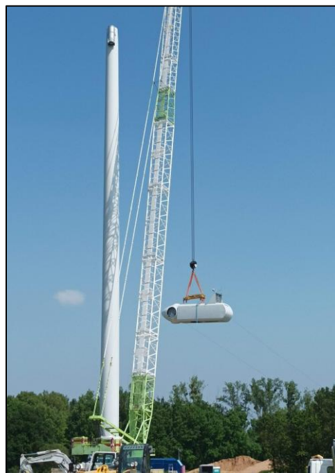
Figure 45 : Exemple de montage d'une éolienne (Source : energieTEAM)
