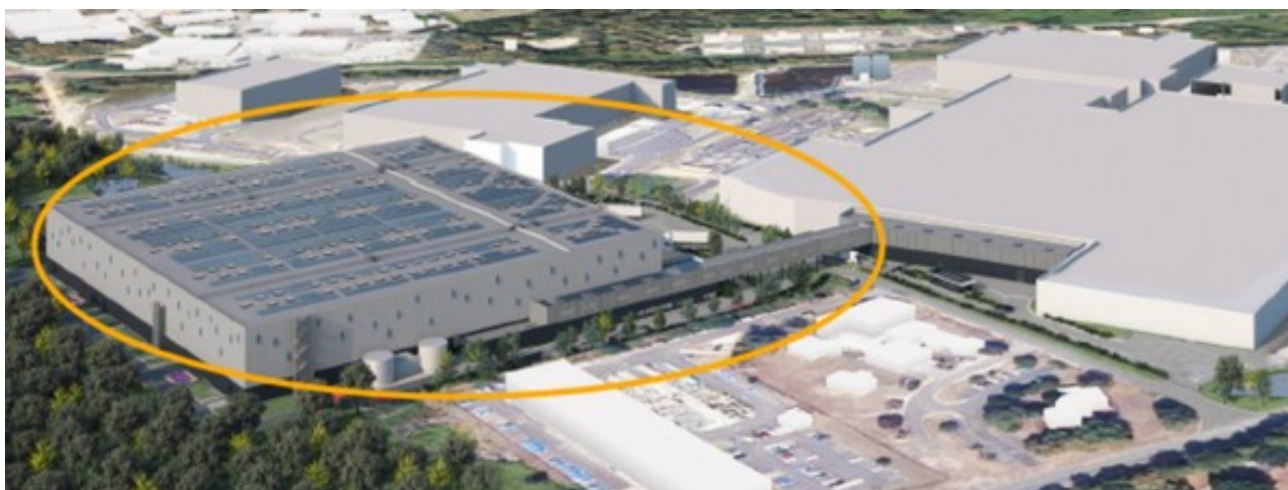
Figure 2 - Vue d'ensemble modélisée du futur entrepôt SCA 7, la passerelle et l'extension de l'entrepôt SCA 2/3 (extrait du dossier du pétitionnaire)
