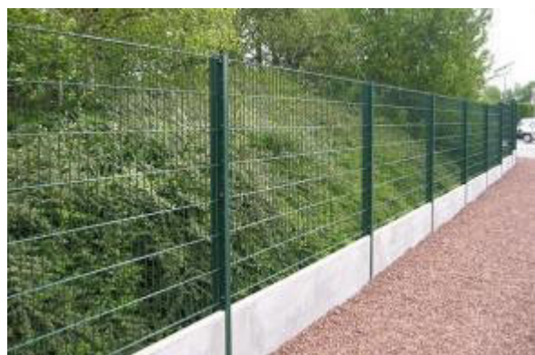
Clôture en treillis soudé avec soubassement béton
