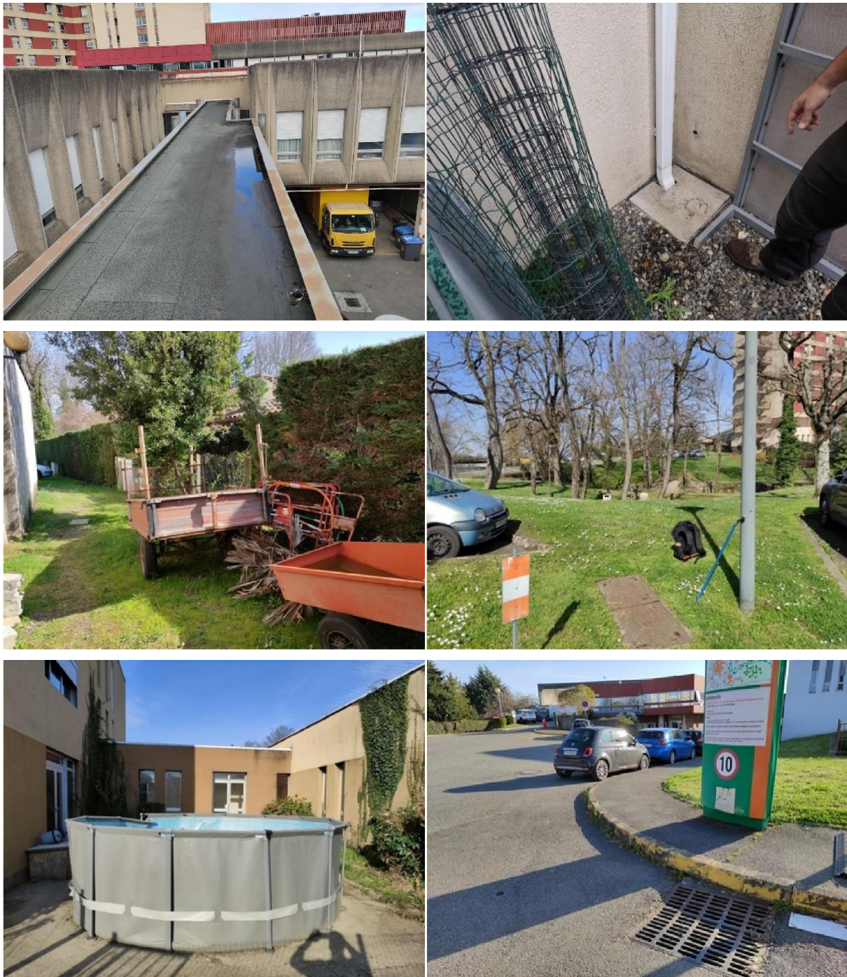
FIGURE 6 : AUTRES EXEMPLES DE GITES EN EAU (DE GAUCHE A DROITE ET DE HAUT EN BAS) : UN TOIT TERRASSE, UNE DESCENTE DE GOUTTIERE, DES REMORQUES DE TRACTEURS, UN COFFRET TECHNIQUE, UNE PISCINE NON ENTRETENUE ET UN COLLECTEUR D'EAUX PLUVIALES
