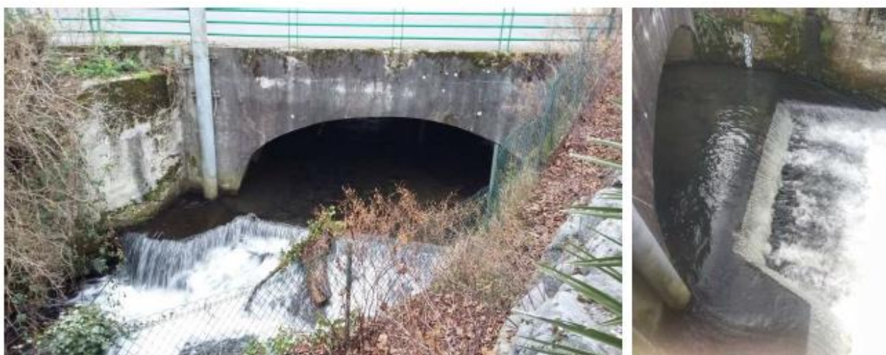
Figure 3 – Station hydrométrique de la Gespe à Tarbes. Photographies issues du rapport CACG, 2020
