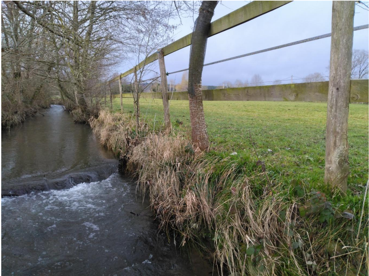
Vue d'un tronc bloqué en travers créant un faciès de plat lentique en amont. Présence d'une légère fosse d'affouillement en aval du tronc. Berge terreuse enherbée.
