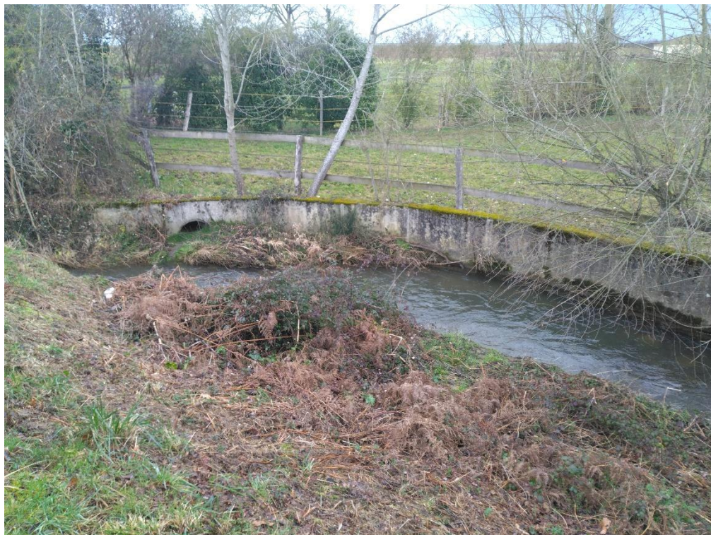
Vue du secteur en sortie aval de l'OH
