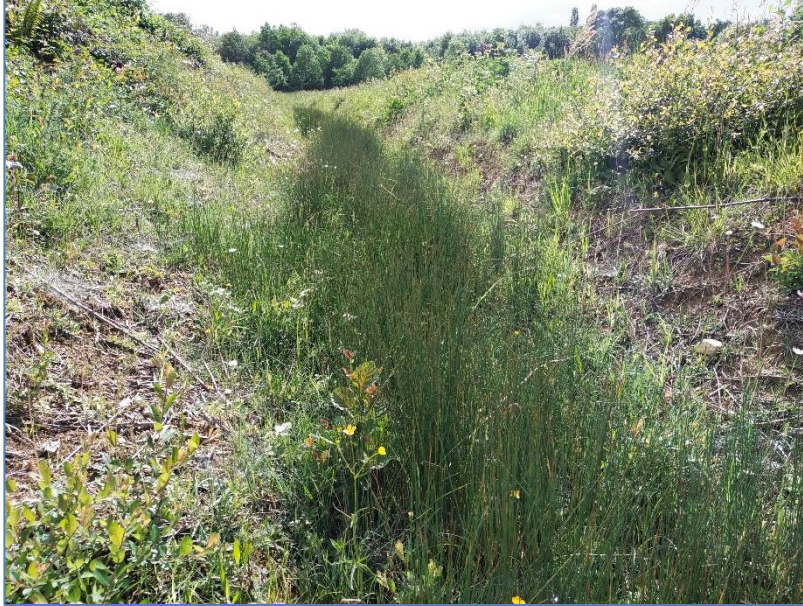
Photo n° 6 : Fossé avec végétation humide
