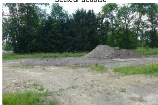
Remblais de la zone humide
