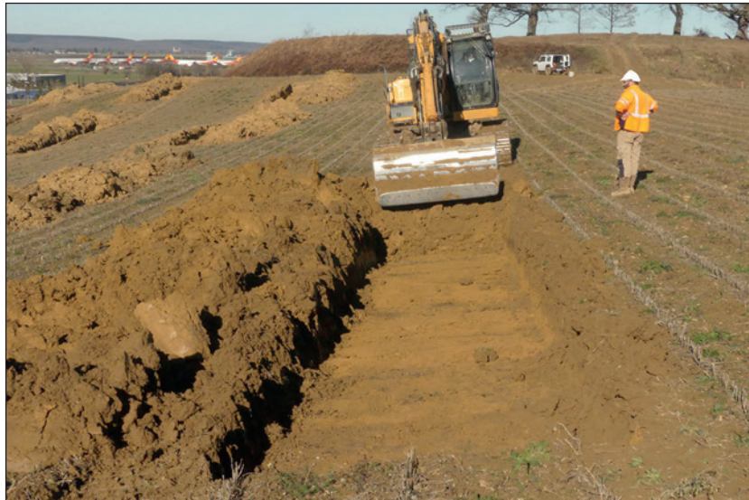
Figure 16 - Une tranchée en cours de réalisation (TR46) (Ph. Gardes, Inrap)
