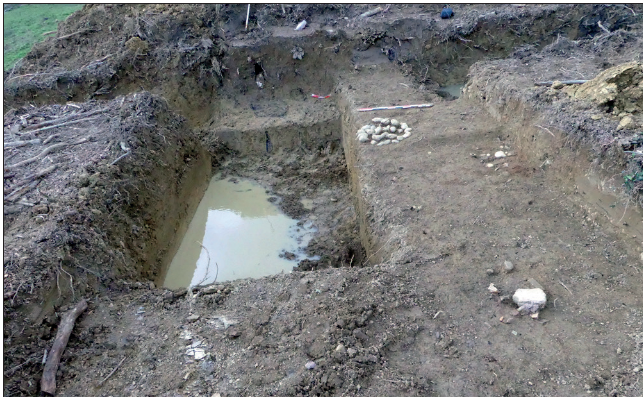
Figure 64 - Vue de l'Us 3012 depuis l'est (Ph. Gardes, Inrap)
