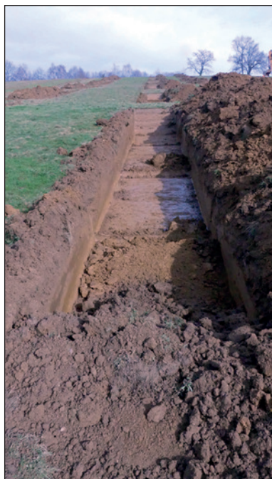
Figure 23 - Vue de la tranchée TR188 depuis le sud (Ph. Gardes, Inrap)
