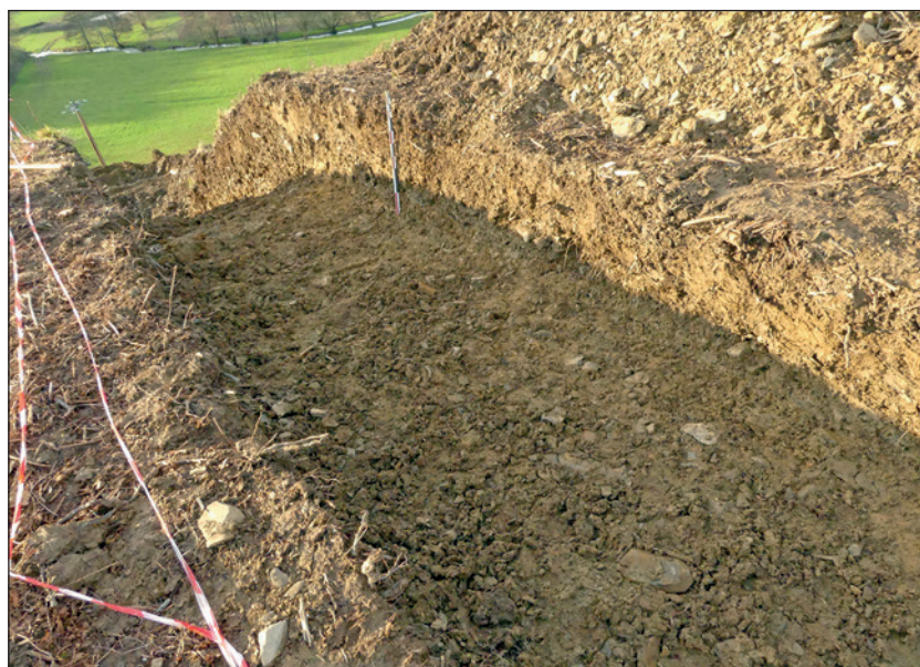
Figure 41 - Vue de la tranchée TR1000 (face nord) et du talus TL1002 (Ph. Gardes, Inrap)
