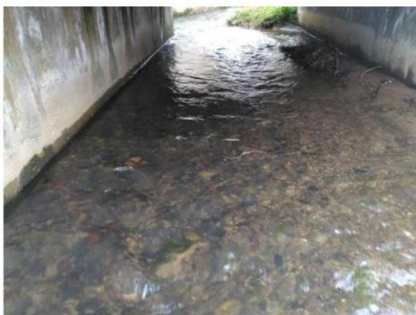
Secteur de l'OH de type pont cadre avec un faciès de plat courant. Atterrissement de limon en RG au sein de l'OH et présence de matériaux au sein de la section d'écoulement.
