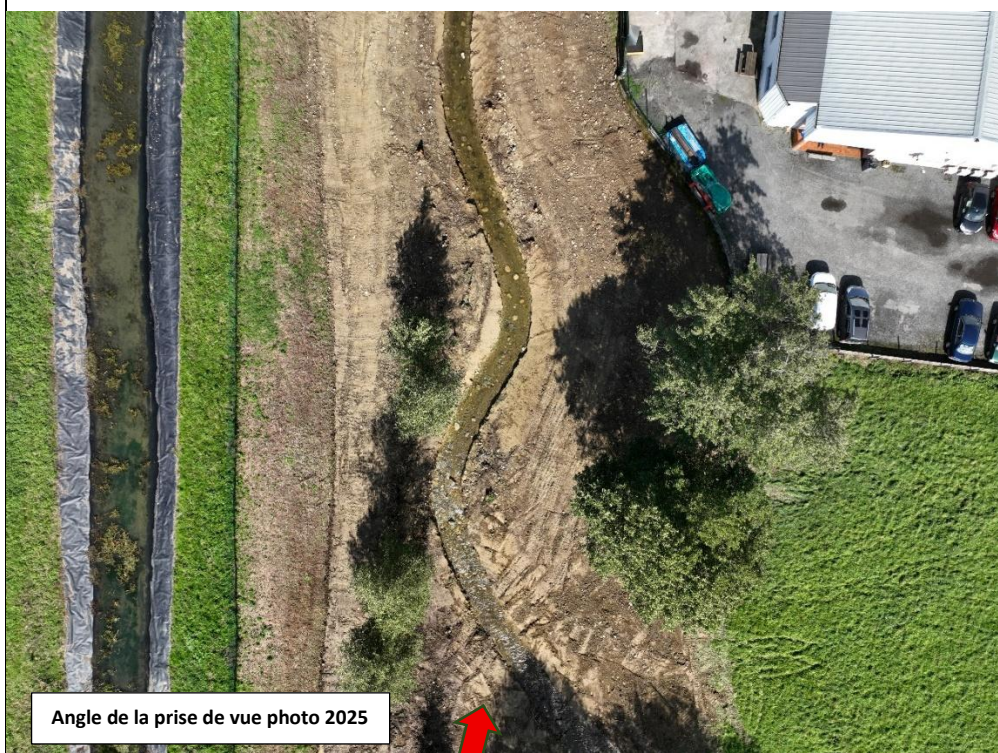
Photographie 1 : Vue de drone du projet de reméandrage de la Geüne porté par le SMAA en 2024, SMAA
