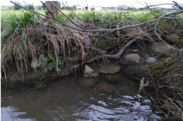
Profil de berge plus hétérogène avec pierres et racines mais enchâssés dans un substrat terreux défavorable à la présence de gîte
