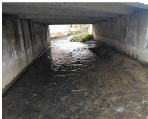
Secteur de l'OH de type pont cadre avec un faciès de plat courant. Atterrissement de limon en RG au sein de l'OH et présence de matériaux au sein de la section d'écoulement.
