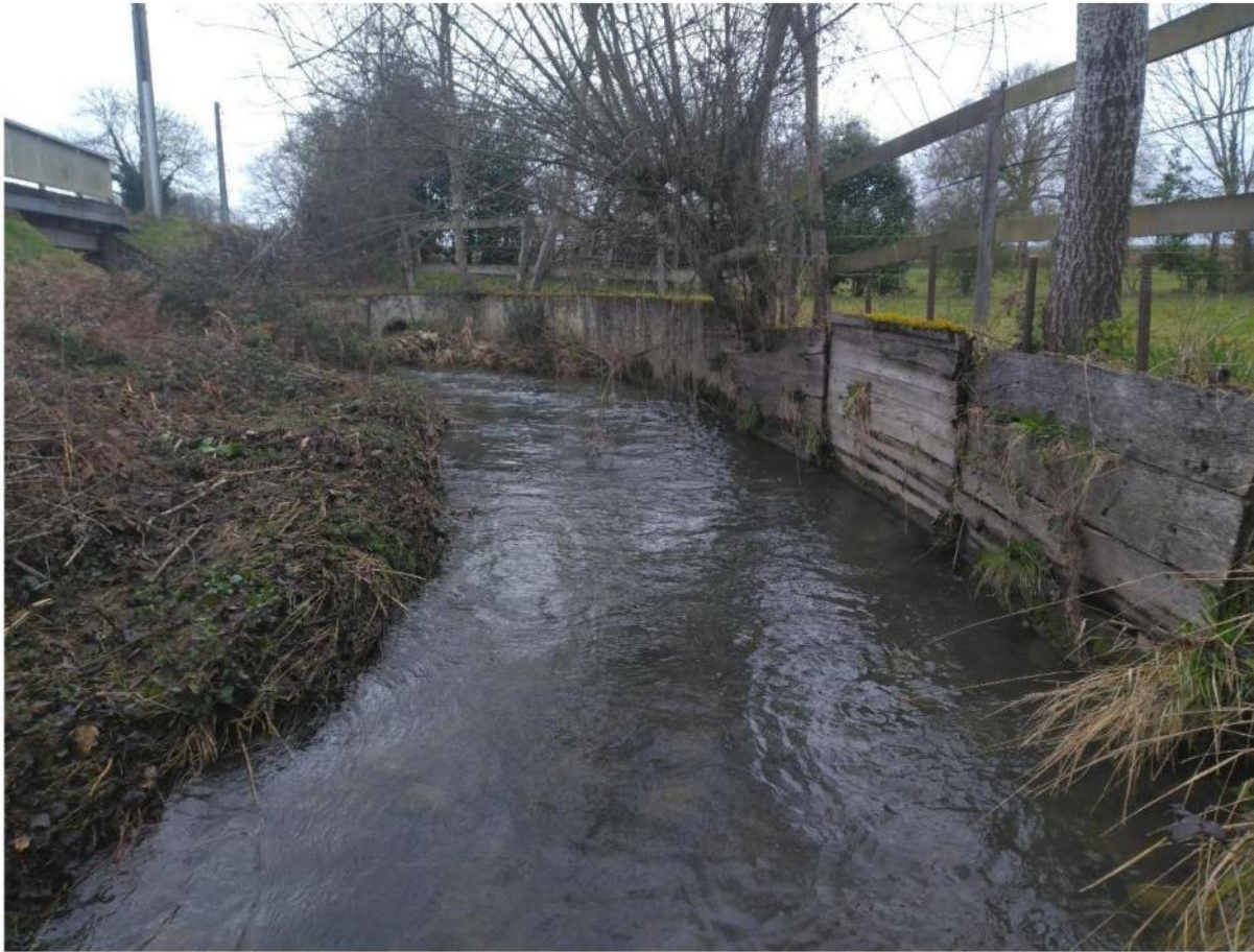
Secteur de virage en aval de l'OH avec un faciès de plat courant, berges asymétriques avec mur béton et planches en RG, ripisylve absente.
