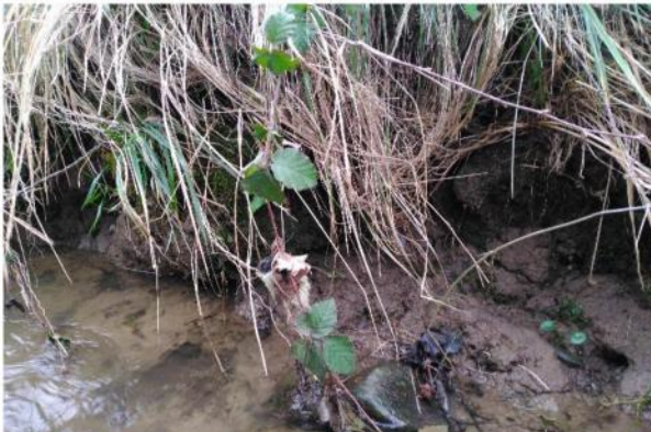
Profil de berge terreuse légèrement sous-cavée mais défavorable à la présence de gîte
