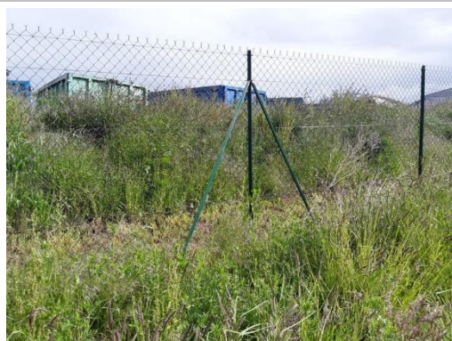
Photographie 4. Talus de BMM (C. Leclerc)
