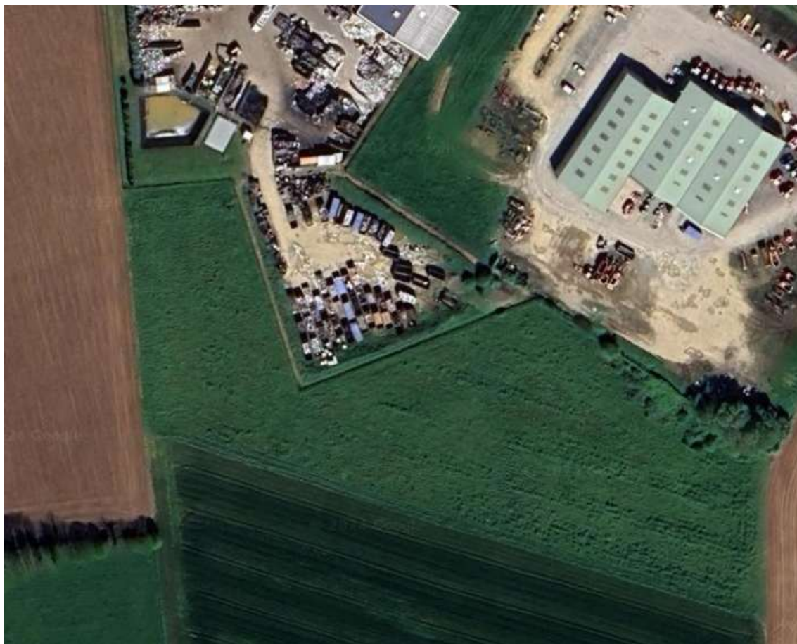
Figure 17 : État du site avant travaux
