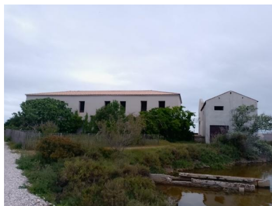
Bâtiments de l'ancienne saliculture
