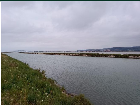
Canal du Rhône – ancien canal de Pierre
