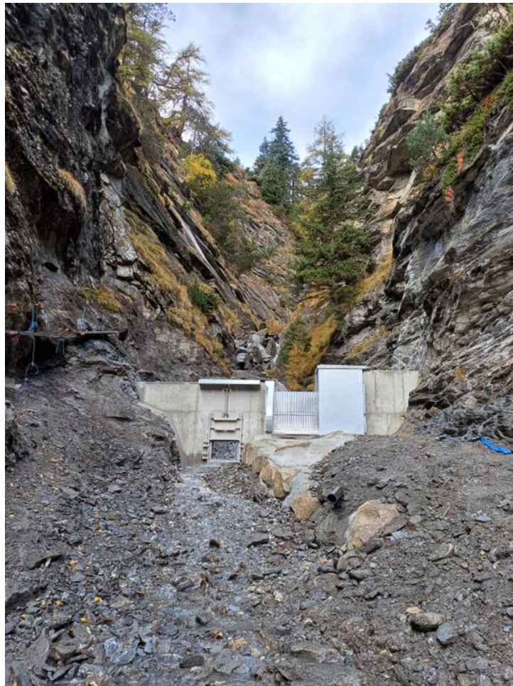
Figure 3 – Prise d'eau sur le Burel vue depuis l'aval
