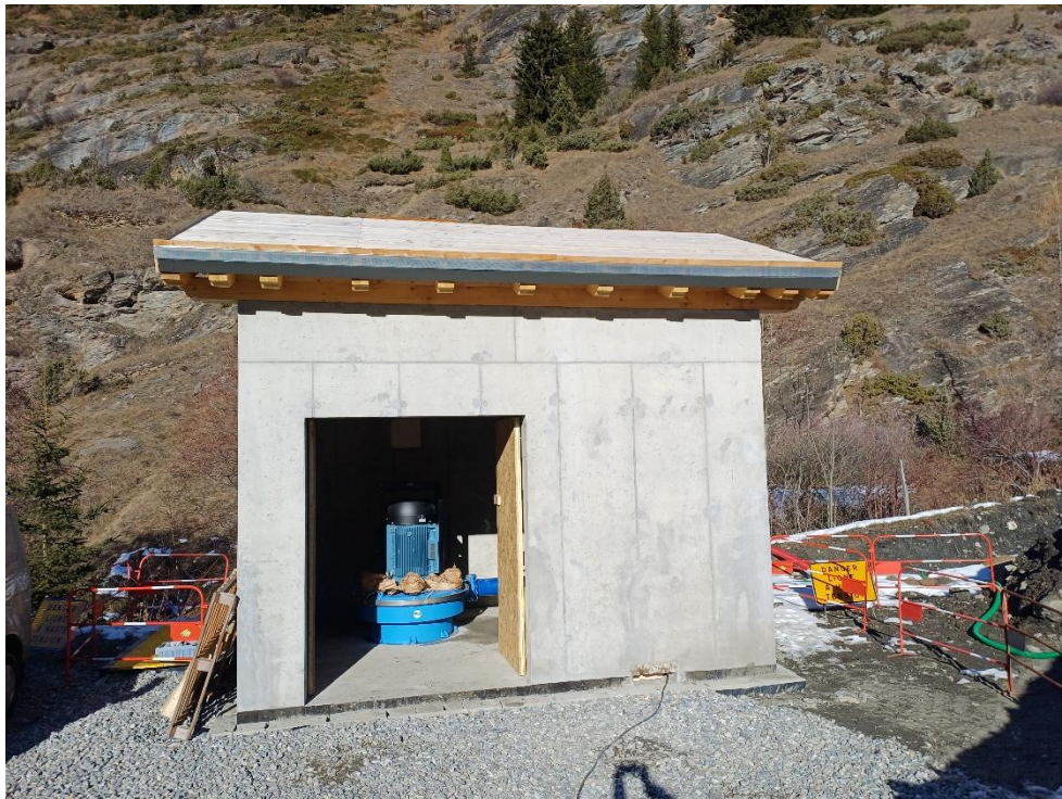
Figure 5 – Microcentrale du Burel (18/12/2025)
