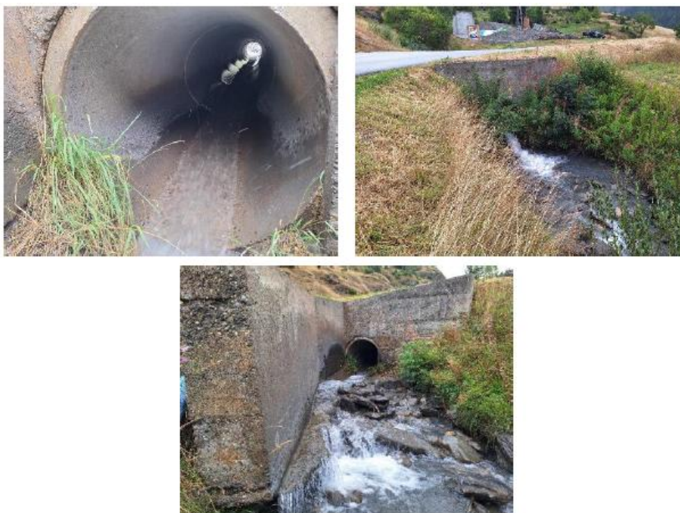
Figure 6 - Buses infranchissables pour la faune piscicole
