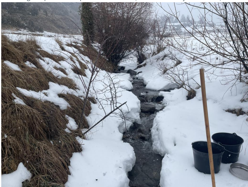
Photographie 13 : Prise en galce partielle du Burel - Janvier 2025
