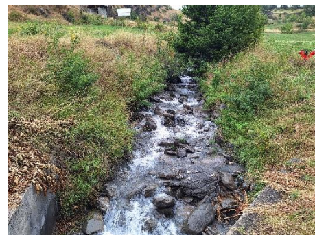
Photographie 3: Vue générale
