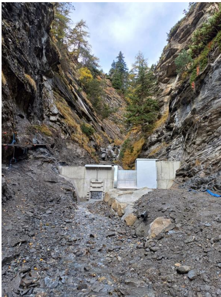
Photographie 1 : Prise d'eau sur le Burel vue depuis l'aval
