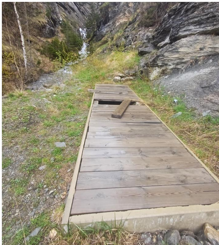
Figure 24: vue du milieu terrestre au droit de la prise d'eau
