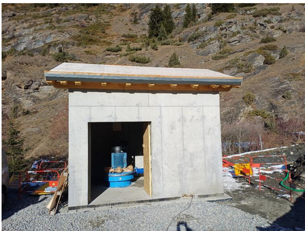
Photographie 2 : Microcentrale du Burel (18/12/2025) (donnée : Hydrostadium)
